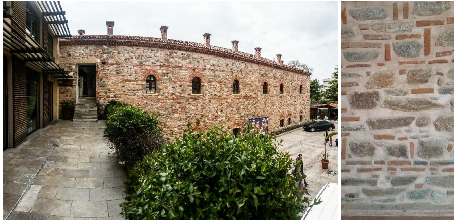
Şekil 3.13. Geyve Han dış cephe-moloz taş ve tuğla kullanımı (Fotoğraf: Büşra Canbakış)
