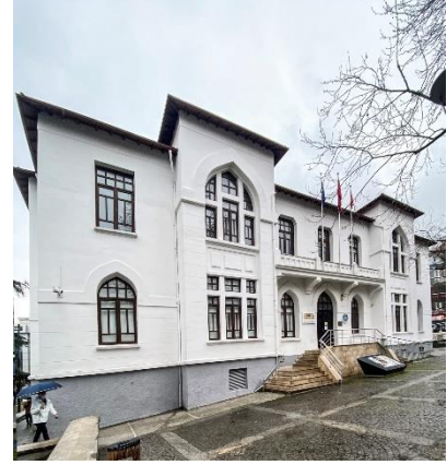
Şekil 3.115. Defterdarlık Binası (Fotoğraf: Büşra Canbakış)
