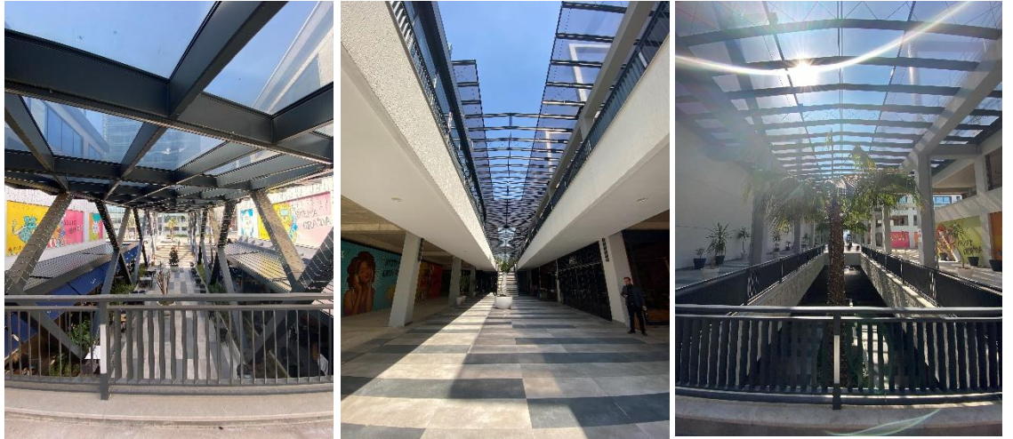
Şekil 3.198. Parkora cam yapı malzemesinin üst örtüde yer alması (Fotoğraf: Büşra Canbakış)
