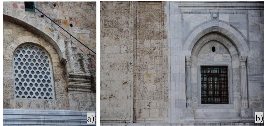
Şekil 3.37. Ulucami kuzey cephesi a) tepe penceresi; revzen, b) Açılır pencere (Fotoğraf: Büşra Canbakış)
