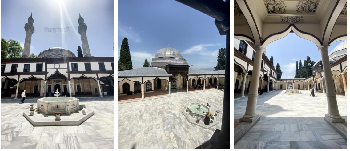
Şekil 3.88. Emir Sultan Cami şadırvanlı avlu ve ahşap kemerli revak (Fotoğraf: Büşra Canbakış)
