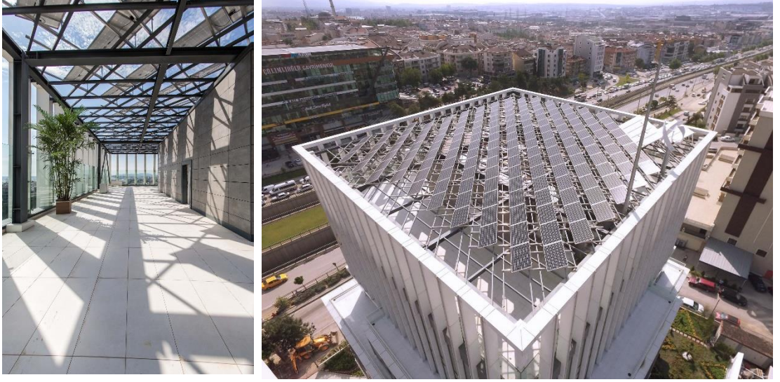
Şekil 3.179. Bursagaz Binası çatı terası ve güneş panelleri (Anonim 2016b)
