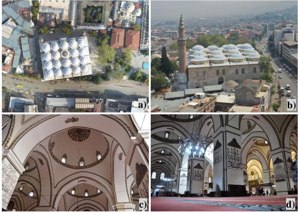
Şekil 4.3. Bursa Ulucami; a) Çok kubbeli Ulucami Hava Fotoğrafı, b) Bursa Ulucami dış cephe ve kubbe, c,d) Ulucami iç mekan (a,b: Anonim 2020f; c,d: Fotoğraf: Büşra Canbakış)
