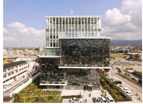
Şekil 3.181. Bursagaz Binası genel görünüm (Anonim 2016b)
