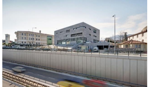
Şekil 3.175. Bursa Merkez Bankası genel görünüm (Anonim 2012)
