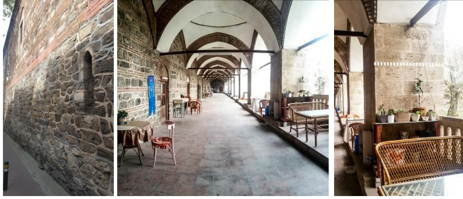
Şekil 3.29. Pirinç Han taş ve tuğla malzemesinin yapıda kullanımı-duvar kalınlığı (Fotoğraf: Büşra Canbakış)
