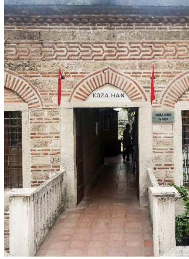
Şekil 3.19. Bursa Koza Han'da Kesme Taş Almaşık Duvar Örgüsü (Fotoğraf: Büşra Canbakış)
