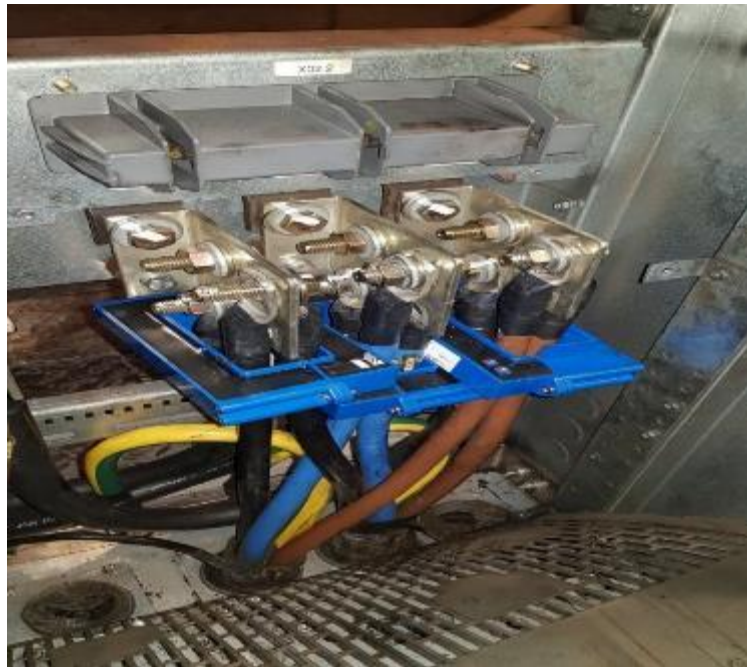
Şekil 3.7 Akım trafosu faz çıkışları montaj görseli
