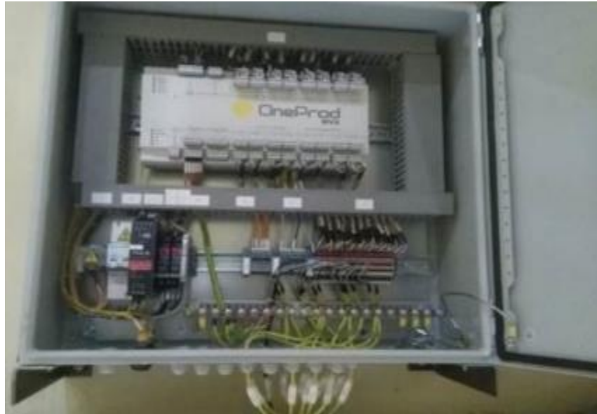
Şekil 3.9 MVX kontrol ünitesi kabin içi bağlantısı
