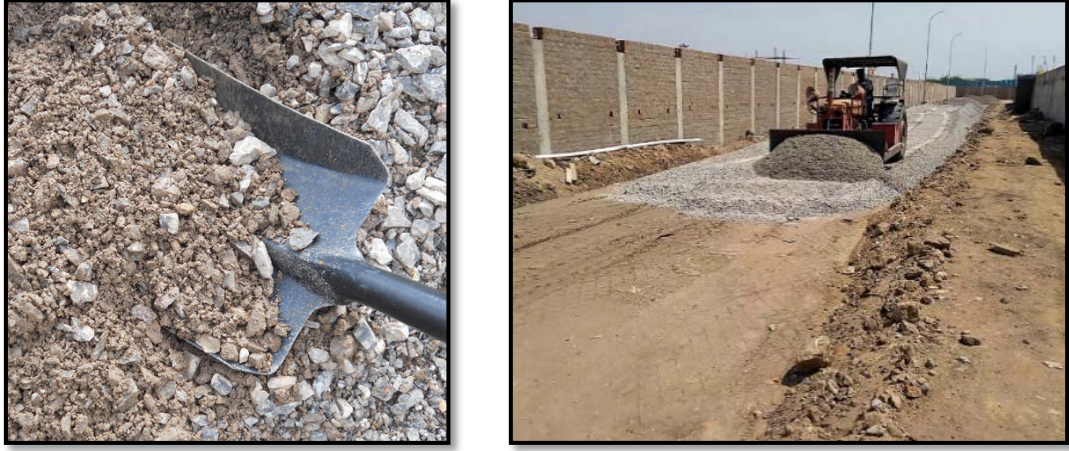
Şekil 2.4. Granüler alttemel malzemesi ve serilme işlemi ( https://pavementinteractive.org/ )
