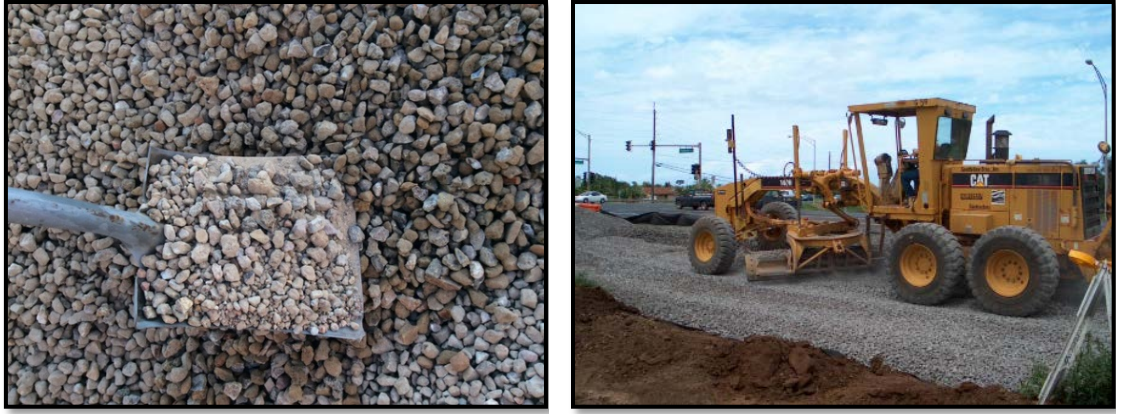
Şekil 2.3. Granüler temel tabakasında kullanılan malzeme ve serilme işlemi ( https://pavementinteractive.org/ )
