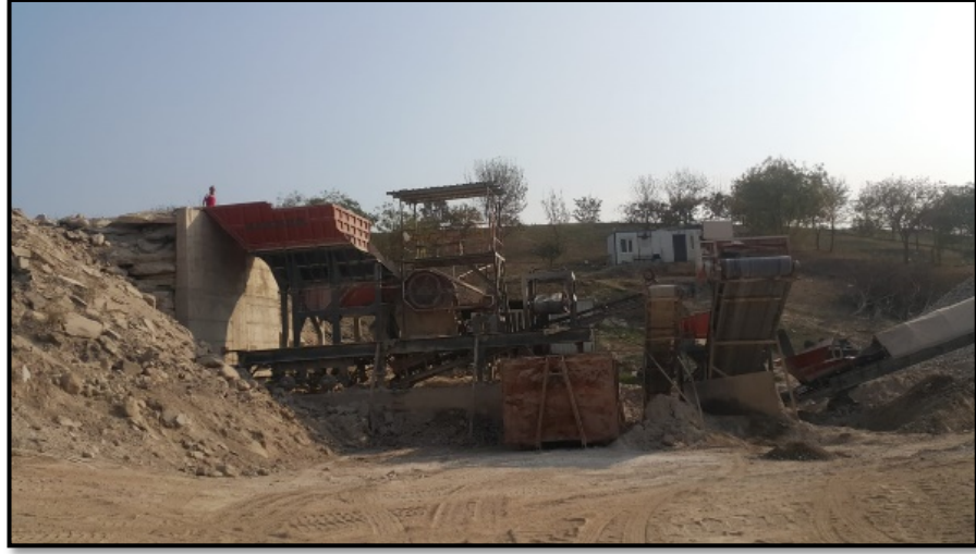
Şekil 3.3. Bursa Büyükşehir Belediyesi Küçükbalıklı Geri Dönüşüm Tesisi
