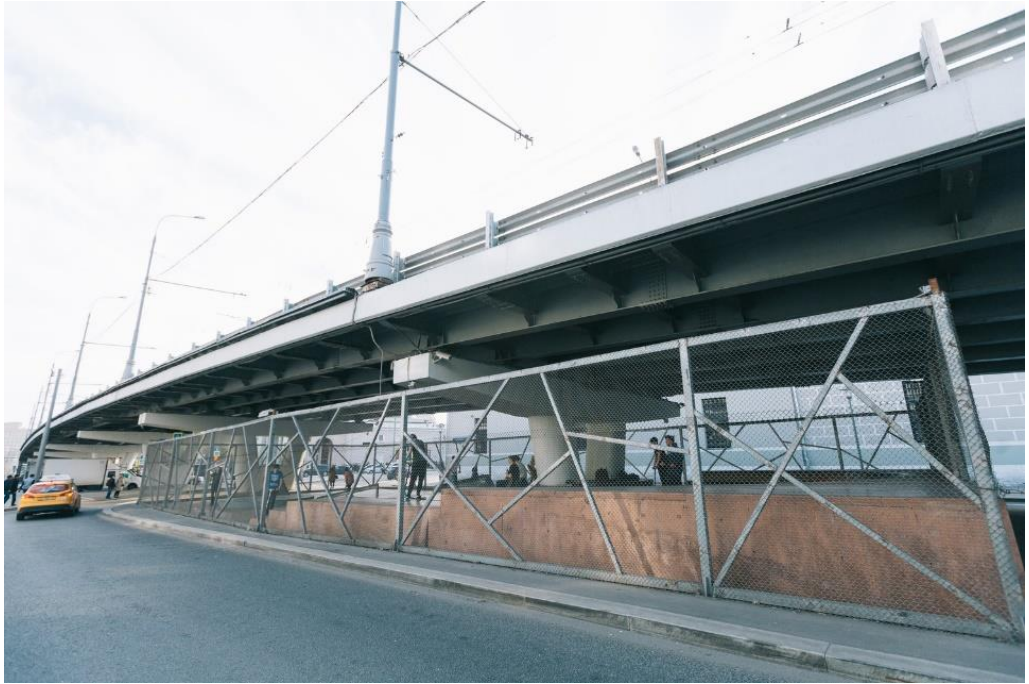
Şekil 3.77. Projenin çitle kapalı dış görünümü (González, 2017)
