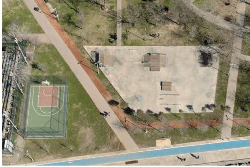
Şekil 3.85. Kalamış Parkının onarımdan önceki durumu (Bayhan, 2016)
