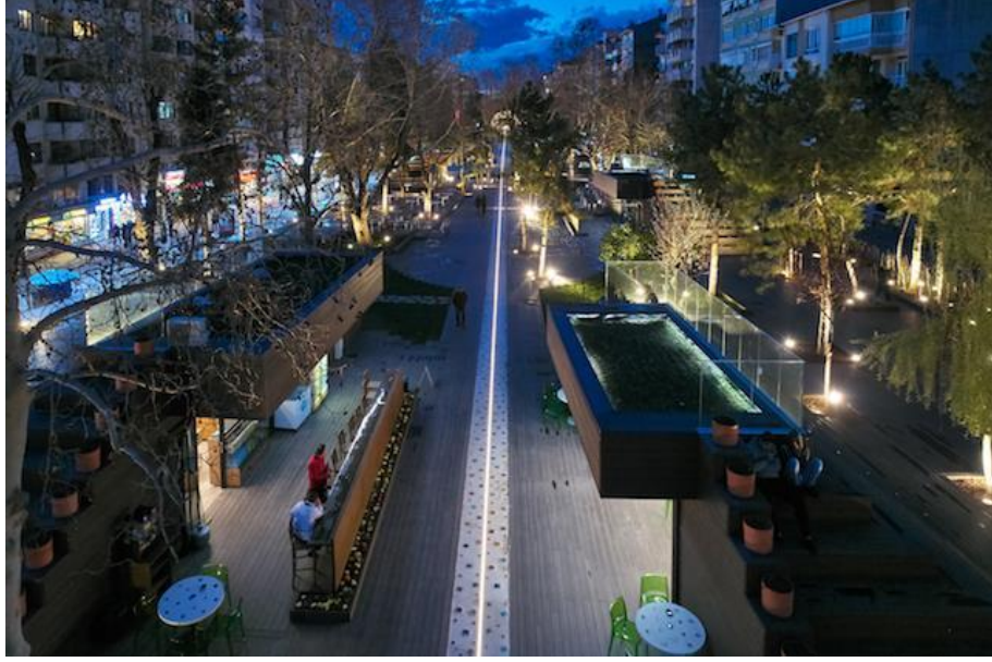
Şekil 3.80. Doğrusal led aydınlatma geçen, el yapımı camların gömülü olduğu beyaz çimentodan oluşan yaya aksı (Vitra, 2018)
