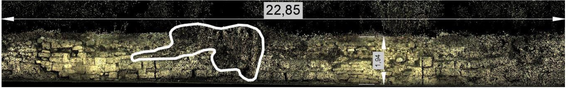
Resim 48: Lafke Kapı su kemerinde mevcut durum
