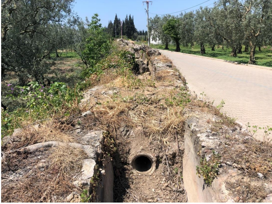
Resim 21: Specusa eklenen beton boru
