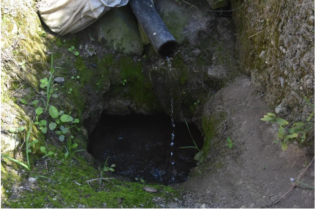
Resim 11: Kapalı su kanalı açıklığı
