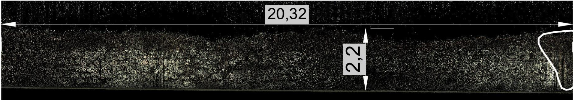
Resim 35: Lafke Kapı su kemerinde mevcut durum
