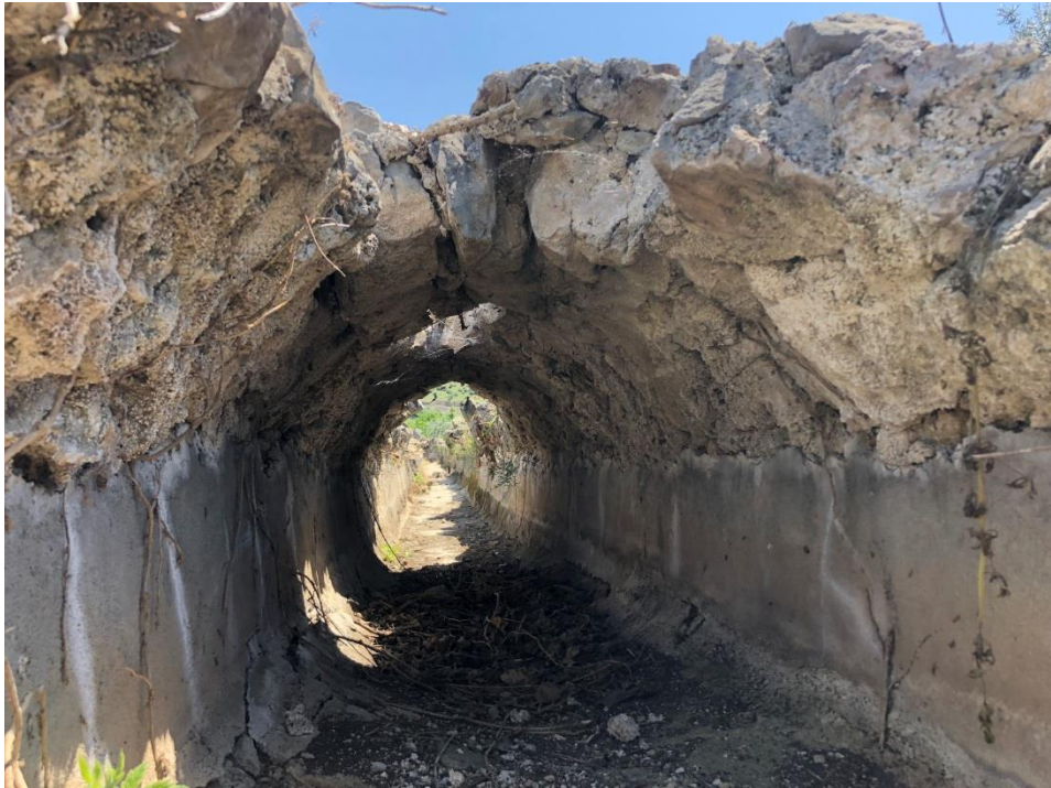
Resim 20: Specus üzerindeki beşik tonoz kalıntıları ve iç kısmı
