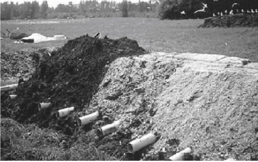
Şekil 2.9 Pasif havalandırmalı yığın metodu (Öztürk M. 2008)
