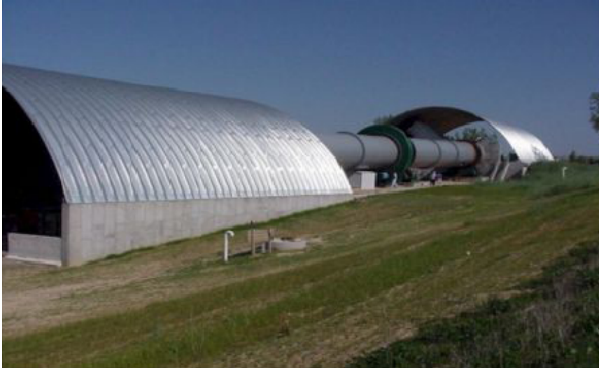
Şekil 2.11 Reaktör kompostlama metodu (Yıldız ve ark. 2009).
