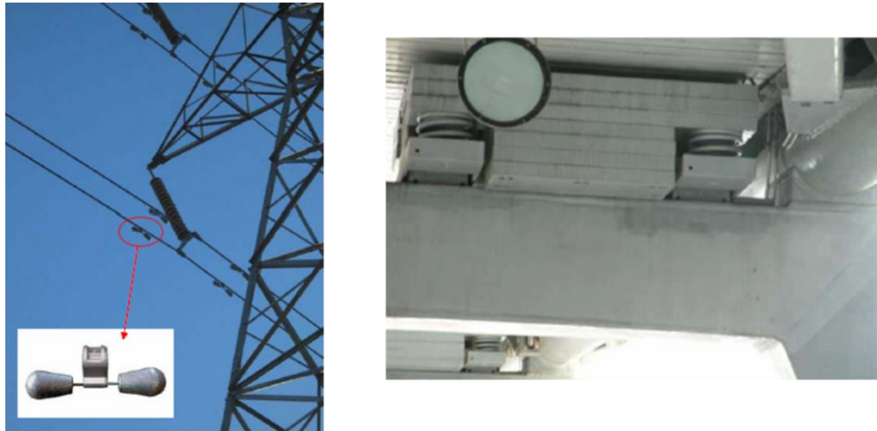
Şekil 1.2 Dinamik absorberlerin çeşitli uygulamaları(elektrik iletim hatları ve köprüler)
