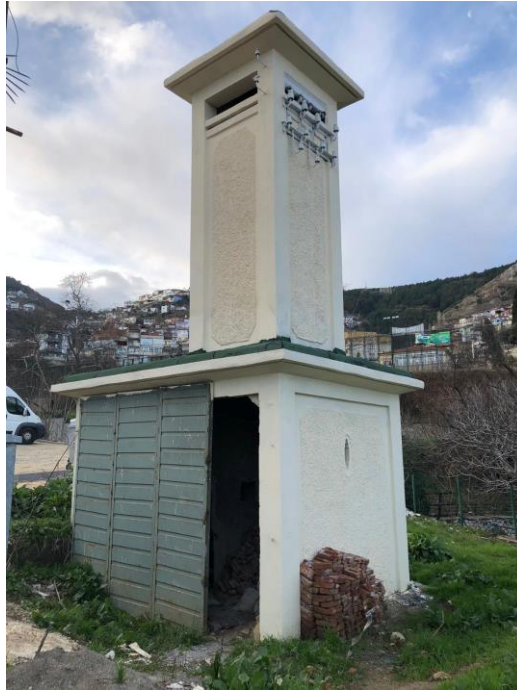
Şekil 3.10. Kaplıca Caddesi üzerindeki trafo yapısı (Deniz arşivi, 2021)
