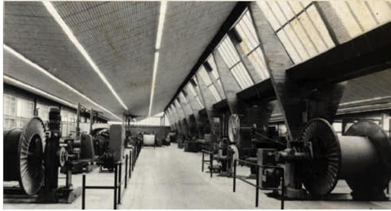
Şekil 3.9. 1970'li yıllarda Mudanya Kablo Fabrikası (Anonim, 2021m)
