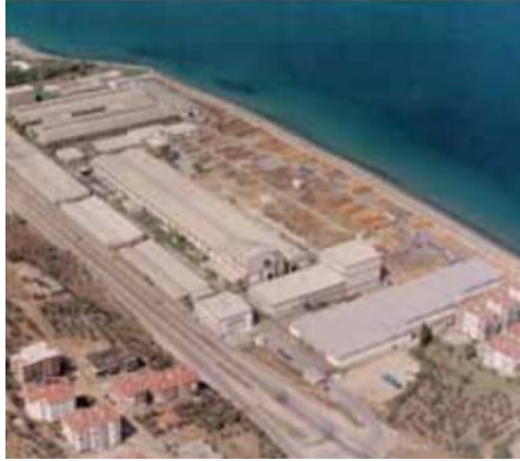
Şekil 4.41. 1980'li yıllarda Mudanya Kablo Fabrikası (Anonim, 2021m)
