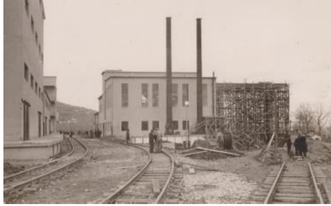
Şekil 4.51. Merinos Elektrik Santrali (Adıman'dan aktaran Sarıgöz, 2018)
