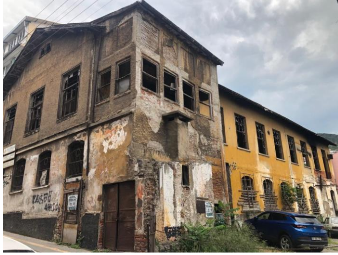
Şekil 4.24. Rıfat Özbek İpek Fabrikası günümüze ulaşan yapısı (Deniz arşivi, 2021)
