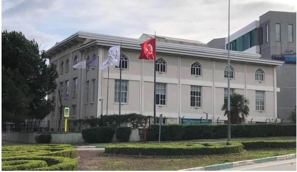
Şekil 4.50. Günümüzde Uludağ Elektrik Dağıtım A.Ş. Binası (Deniz arşivi, 2021)
