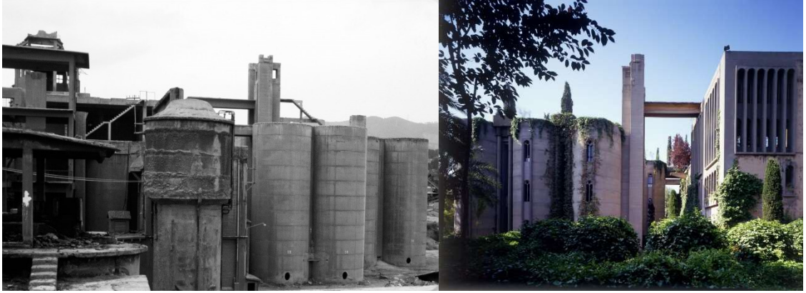
Şekil 2.50. Yapının geçmiş ve günümüzdeki hali (RBTA, 2019)
