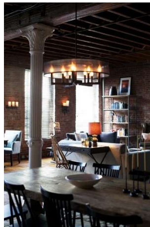
Şekil 2.16. Ahşap döşeme kirişlerinin, tuğla duvarların ve metal dikmelerin açıkta bırakıldığı, loft dönüşümü geçirmiş bir konut yapısı (HGTV, 2019)
