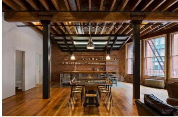
Şekil 2.23. Ahşap döşeme kirişlerinin açıkta bırakıldığı bir loft dönüşüm örneği (Ganea, 2015)
