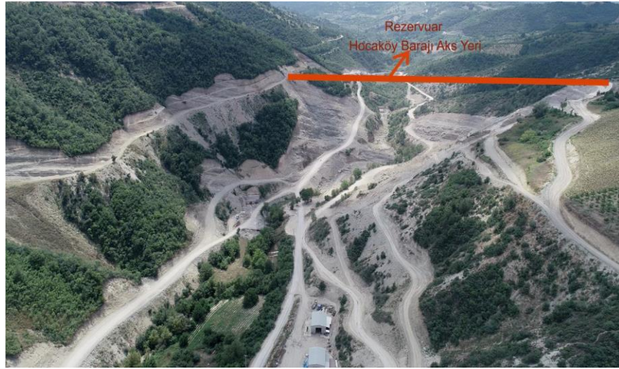
Şekil 3.2. Hocaaköy Barajı inşaat alanı mansaptan membaya doğru görünümü (Özgün, 2019)
