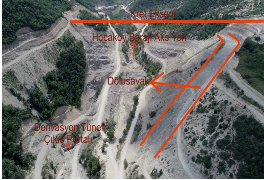
Şekil 3.1. Hocaaköy Barajı inşaat alanı mansaptan görünümü (Özgün, 2019)
