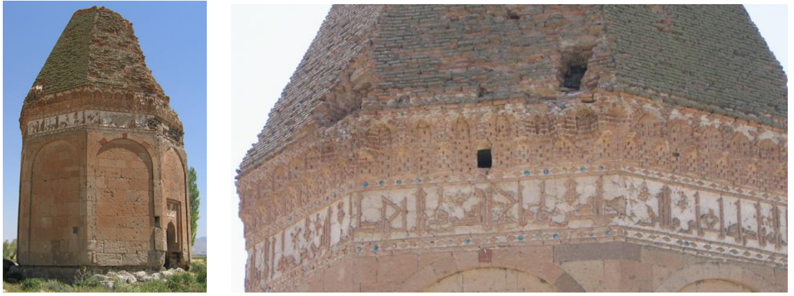
Şekil 11-12: Onarımdan önce Bekar Sultan Türbesi'ndeki bacini (Konya VBM Arşivi).
