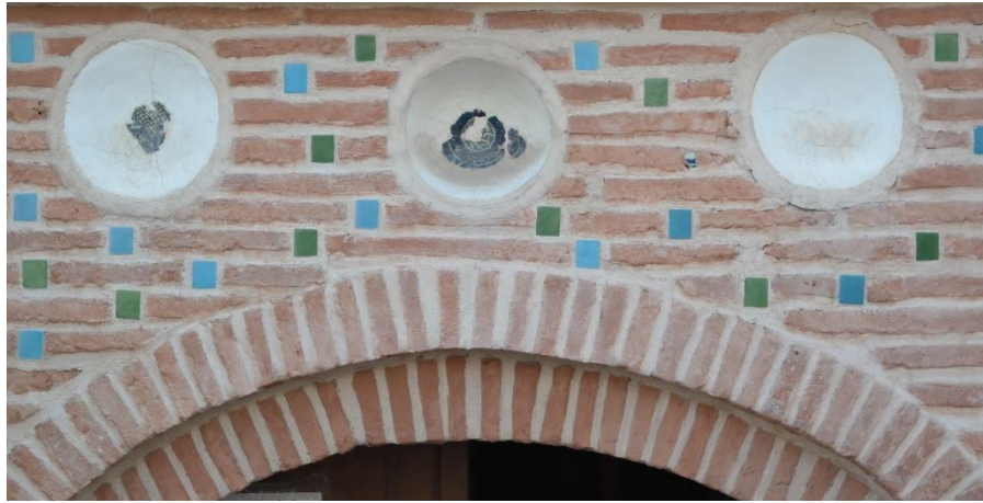
Şekil 33: Arslanhane Camii'nin doğu girişindeki seramik yuvaları ve seramikler (Köse, 2021).
