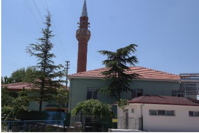
Şekil 198: Susuz Köyü Camii güneyden görünüş (Köse, 2021).
