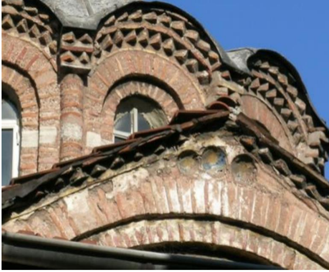
Şekil 3: Vefa Kilise Camii'ndeki bacini yuvaları (Esmer, 2012). Şekil 4: Seramik parçaların görünüşü (Esmer, Ahunbay, 2013).
