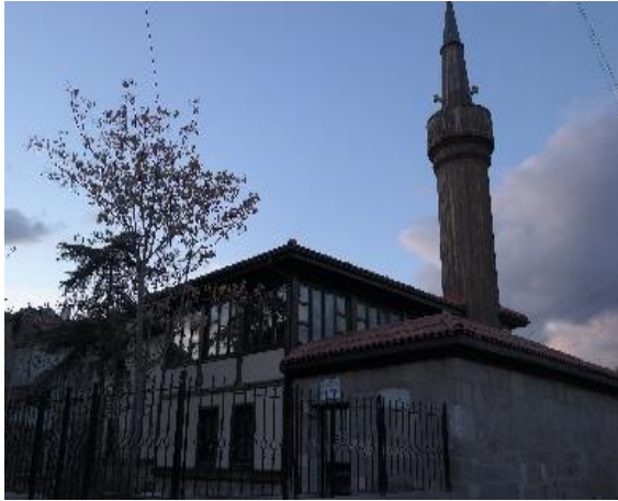
Şekil 116: Molla Büyük Camii kuzeydoğudan görünüşü (Köse, 2021).
