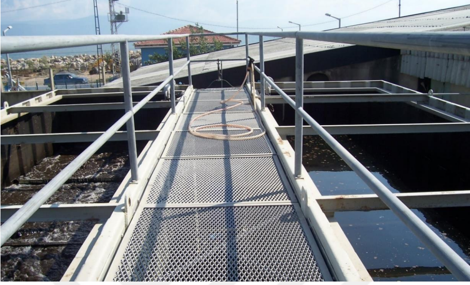
Şekil 3.4. Çökeltim havuzları
