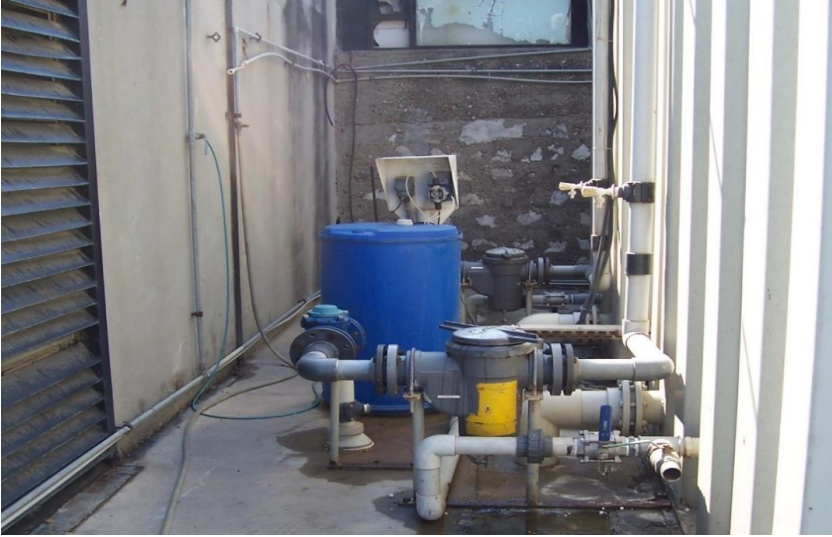
Şekil 3.11. Klorlama tankı
