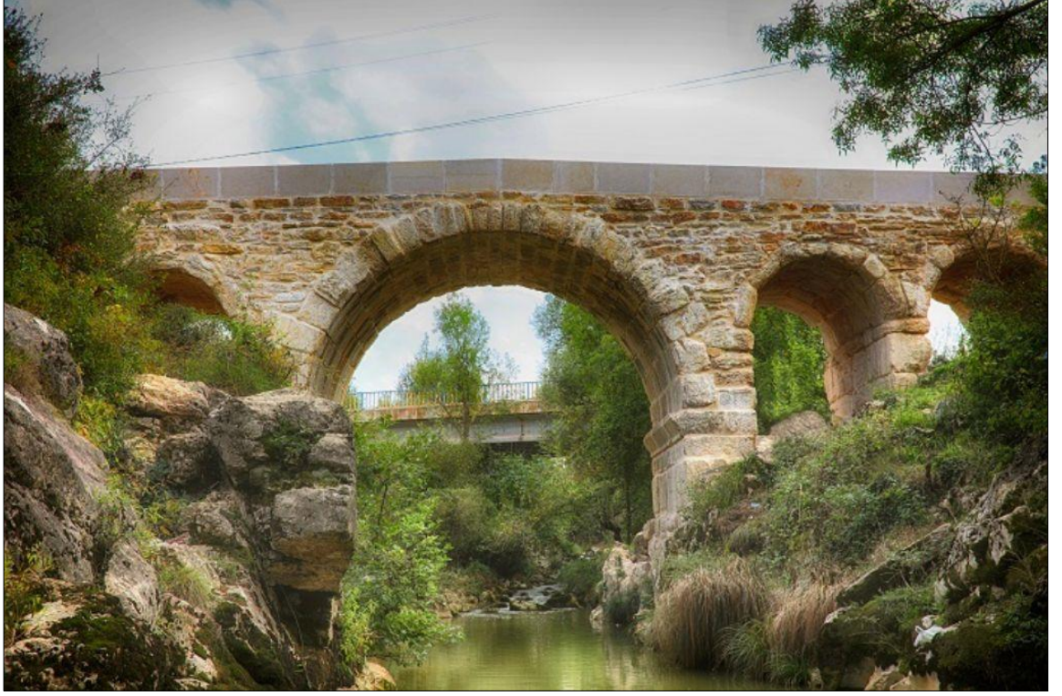
Resim 36: Kutluca Köyü Tarihi Taş Köprü (Restorasyondan Sonra)
