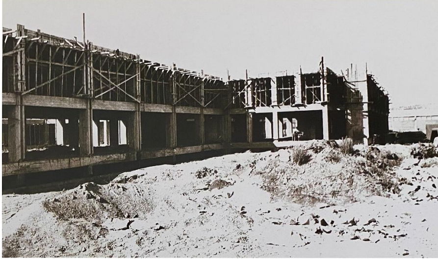
Şekil 3.7. Temel Tıp Bilimleri binasının inşaatı (Anonim 2006a)
