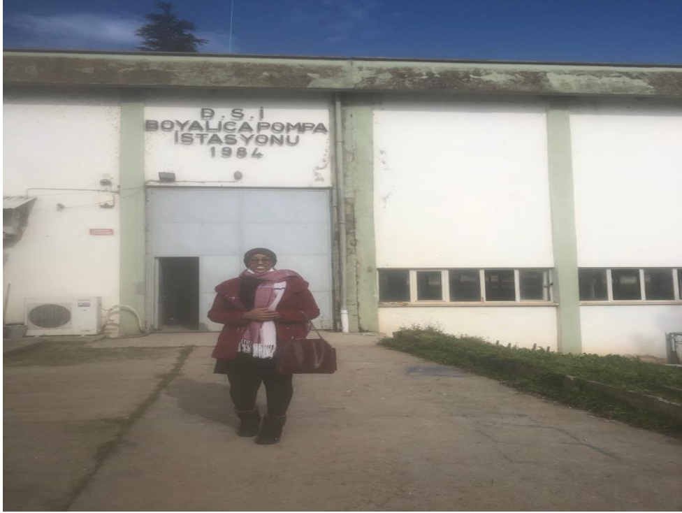
Şekil 3.4. Boyalıca Pompaj İstasyonu Binası
