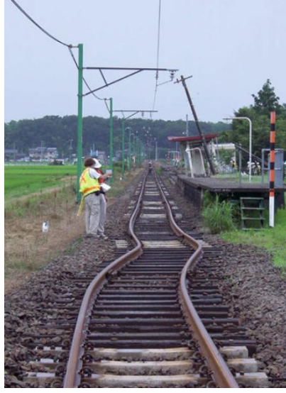
Şekil 2.52. Deprem nedeniyle raylarda meydana gelen yanıl deformasyon (Azevedo ve diđerleri, 2009)
