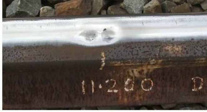
Şekil 2.60. Ray yüzeyinde oluşan çökme (Iwnicki S. D., 2009)
