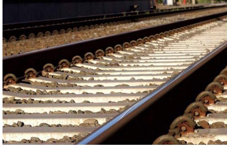
Şekil 2.18. Vinyol ray tipi örneği (Anonim, EN 13674-1 Demiryolu Uygulamaları - Demiryolu Hattı - Ray - Bölüm 1: 46 kg/m ve Üzeri Vignole Demiryolu Rayları, 2022)
