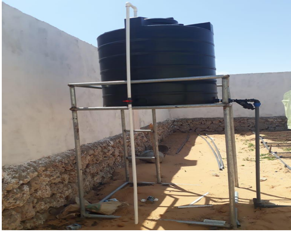
Şekil 4.23. Kaynağından alınan suyun su deposuna aktarılması ve filtreleme
