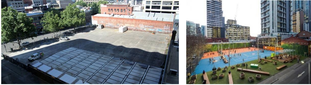
Şekil 2.8. A'beckett Urban Square projesinin eski ve yeni hali (Anonim b).
