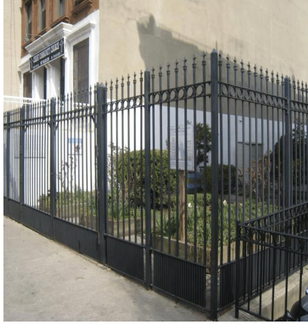
Şekil 2.7. 1964’de New York Harlem bölgesinde yapılan bir cep park (Armato 2017).
