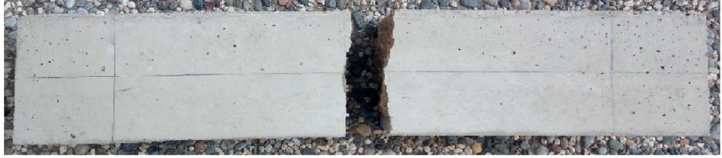
Şekil 4.13. Lifsiz kirişlere ait yükleme grafikleri ve örnek hasar mekanizması (%0)
