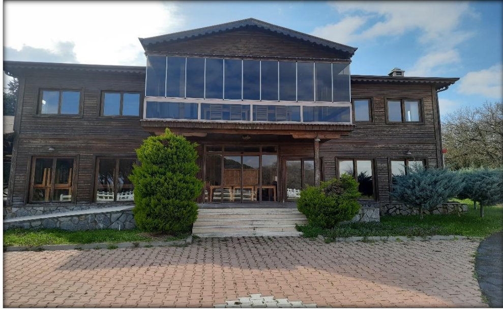
Fotoğraf 48: Karacabey TİM Kahvaltı Tesisinden Görünüm
