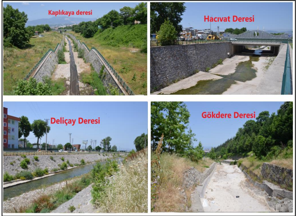
Fotoğraf 6. Yapay kanallar ve oluşan geçirimsiz yüzeyler
