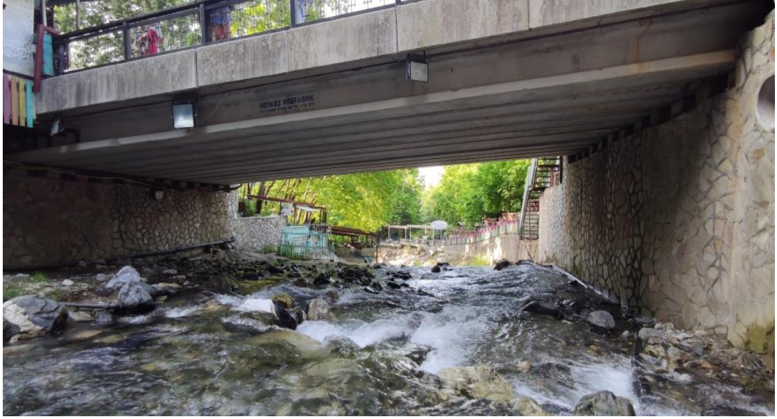
Fotoğraf 7. 2011 yılındaki selde yıkılan Seyitabat köprüsünün yeni hali
