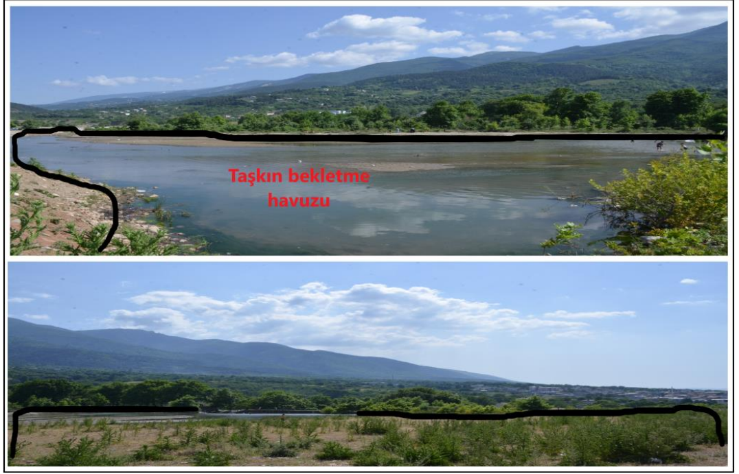
Fotoğraf 12. Gelen alüvyonlarla zaman içerisinde dolan taşkın bekletme havuzu.
