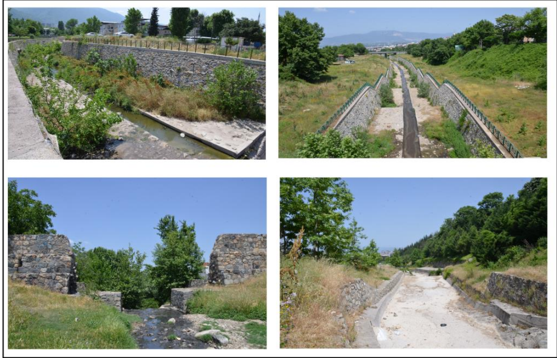
Fotoğraf 10. Alüvyal fanlar üzerindeki akarsularda daraltma ve betonlama çalışması örnekleri
