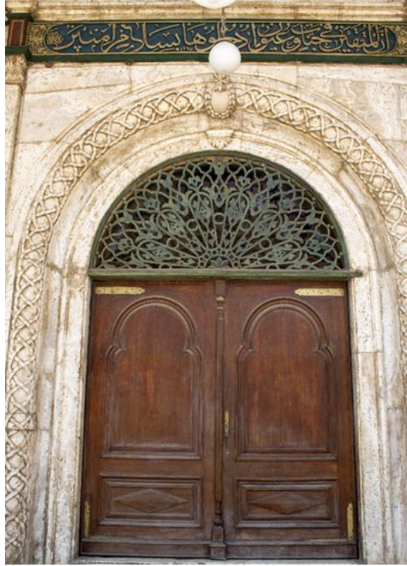
Şekil 122. Mehmet Ali Paşa Camii'nin kuzeydoğu girişinin görünümü (Kahire'deki Kal'atülcebel, 10-06-2022).
