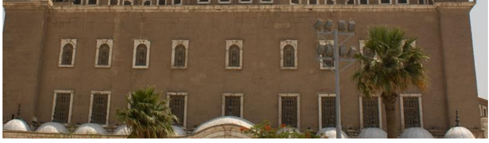
Şekil 86. Duvarların üst kısmında bulunan pencereler (Kahire'deki Kal'atülcebel, 10-06-2022).
