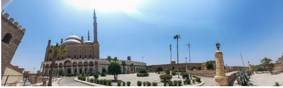
Şekil 34. Caminin kuzey cephesi ve camiye batıdan çevreleyen avlu kısmının görüntüsü (Kahire’deki Kal’atülcebel, 10-06-2022).
