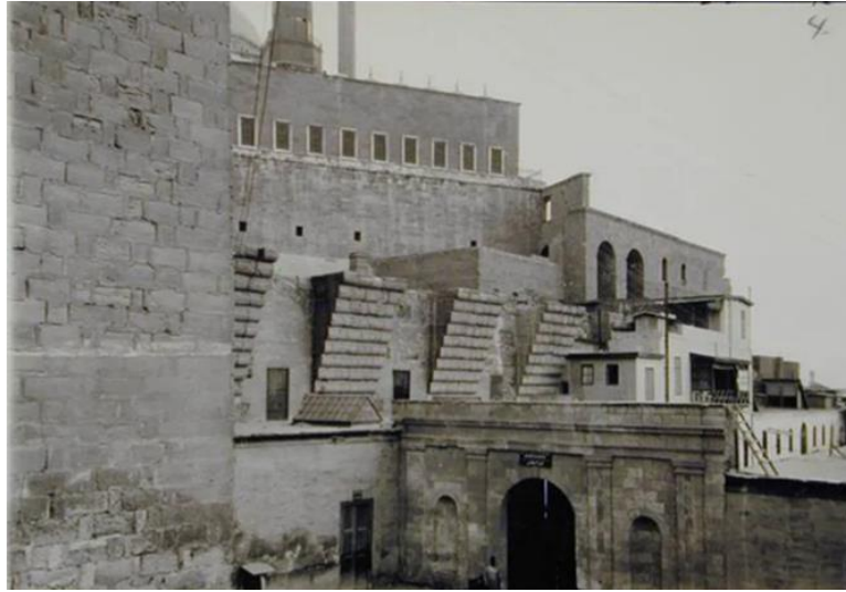
Şekil 46. Al-Qasr Al-Ablağ'ı destekleyen kornişler ( https://www.archnet.org/sites/218?media_content_id=33908 ; Erişim Tarihi: 25-06-2022).
