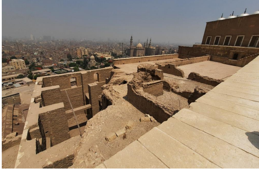
Şekil 47. Son zamanlarda yapılan kazılar (Kahire'deki Kal'atülcebel, 10-06-2022).
