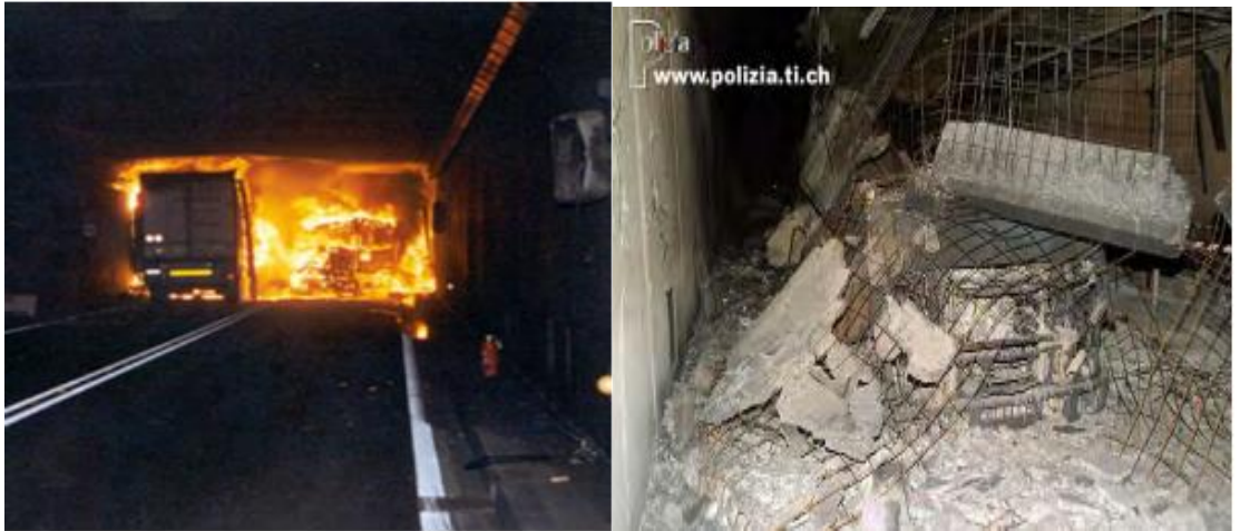
Şekil 1.2 Gotthard tüneli yangını ve verdiği hasar görüntüleri (Haack, 2003)
