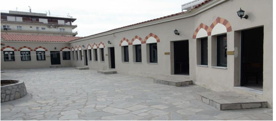
Ek 12: Gümölcine Kayalı Medresesinin günümüzdeki yurt olarak kullanılan binası.
