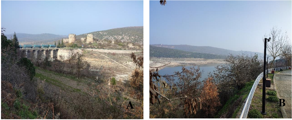
Şekil 3.3. İkizcetepeler Barajı A) Baraj Rezervuarı B) Baraj Membası
