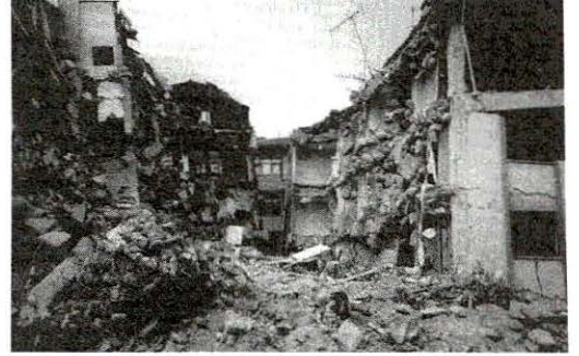
Çarpık yerleşme, kötü zemin, kötü işçilik, kalitesiz malzeme vb.nedenlerle depremin yapılarındaki hasar
