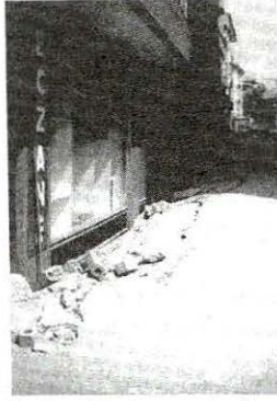
Zemin çökmesi sonucu cadde üzerindeki yapıların hasarı/İZMİT
