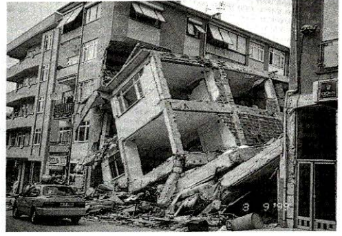
Bir yapıdaki deformasyonun sağlam binaya verdiği hasar / ADAPAZARI
