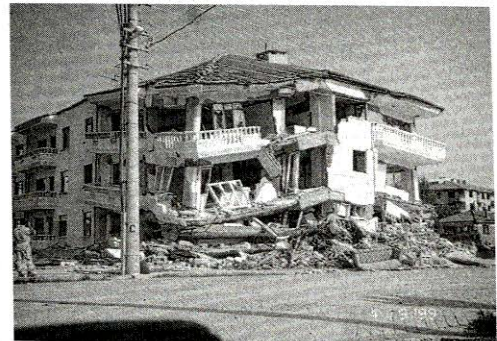
Alt katların ani göçmesi ve binada oluşan ağır hasar / YALOVA
