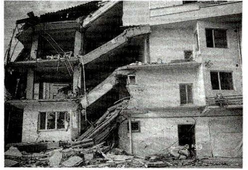
Geniş açıklık, farklı oturma ve bölümsel göçme / YALOVA
