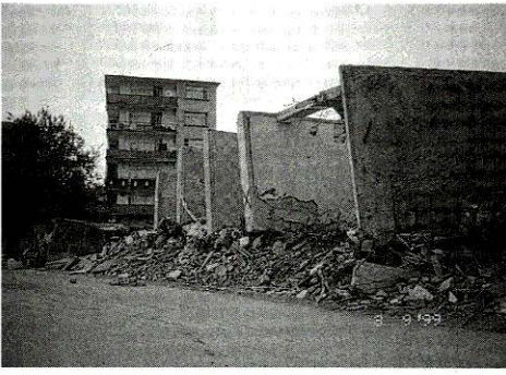
Burkulma nedeniyle yapının yan yatması / GÖLCÜK
