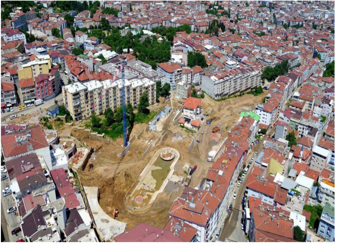
Şekil 4.9. Sular Vadisi inşaat çalışmaları (Anonim, 2022ş).
