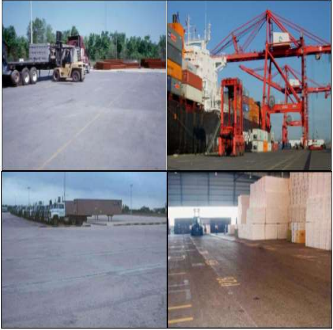
Şekil 2.3. Endüstriyel zeminlerde SSB uygulaması (Mardani-Aghabaglou, 2011)
