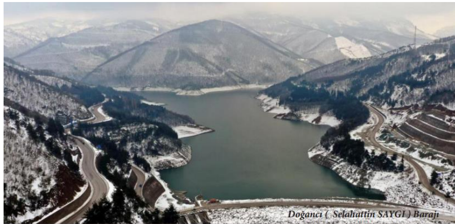
Şekil 3.1.2 Doğancı Barajı (BUSKİ, 2020)
