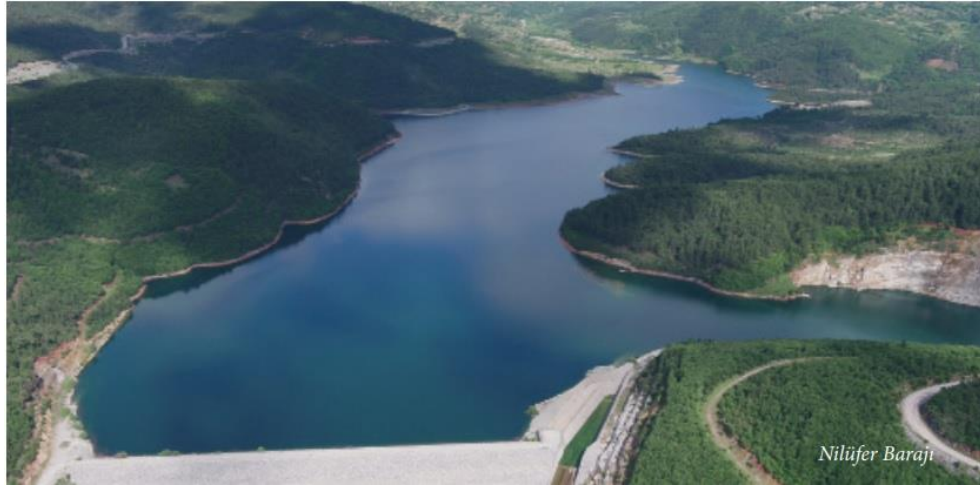
Şekil 3.1.3 Nilüfer Barajı (BUSKİ, 2020)
