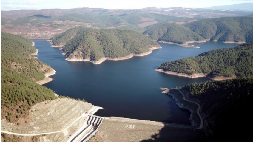
Şekil 3.1.4 Çınarcık Barajı (Anonim, 2022)
