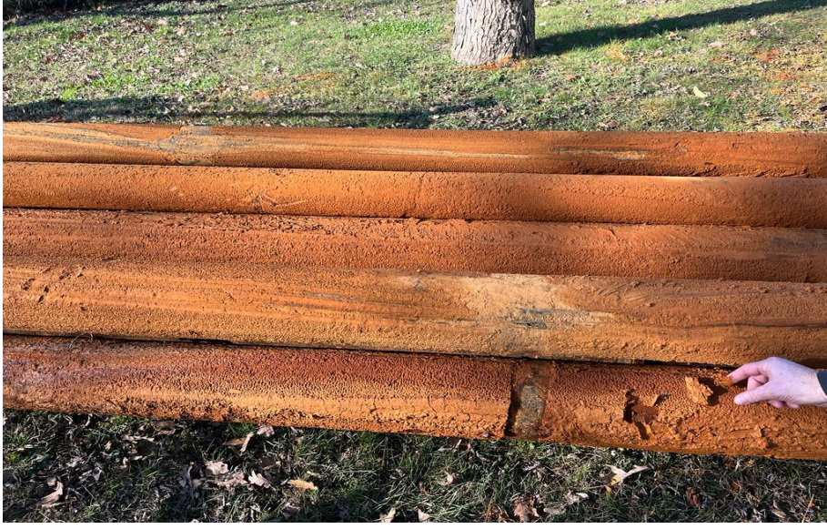
Şekil 4. 8. 3/3 nolu kuyudan çıkarılan kolon boruları
