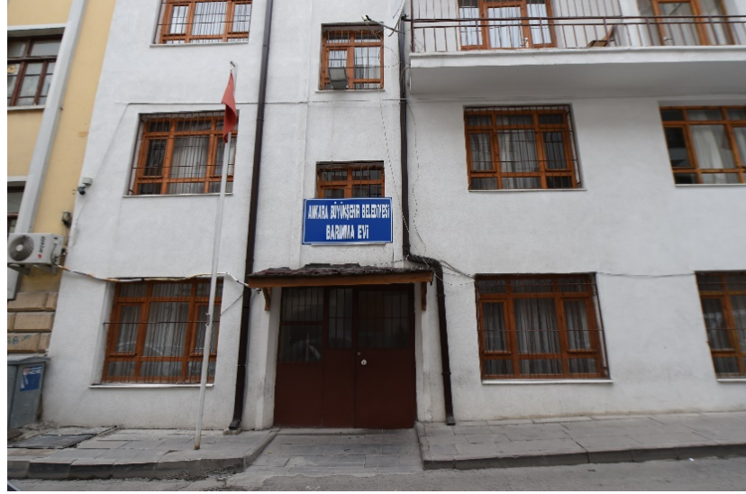
Şekil 2.9. Ankara Büyükşehir Belediyesi Barınma evi girişi (Ankara Büyükşehir Belediyesi, 2023)
