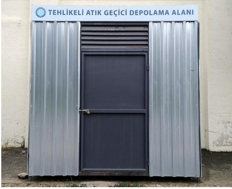
Şekil 3.10. Tehlikeli atık geçici depolama alanı
