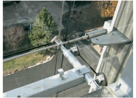
dış cephe kablo destekli ve bağlantı noktayla yapım çekimi
