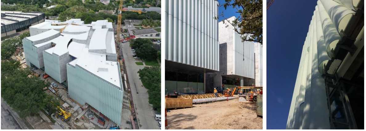
Şekil 4.9.4. Houston'daki Güzel Sanatlar Müzesi giydirme cephe sisteminin uygulama aşaması ( https://www.stevenholl.com/project/kinder-museum-building/ ).
