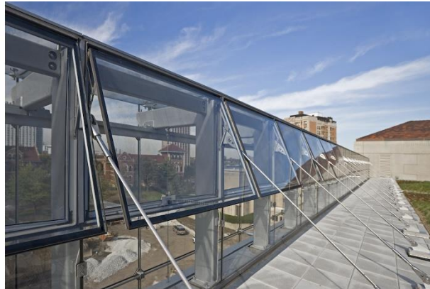
Doğu otomatik çalışan havalandırıcı pencereler
