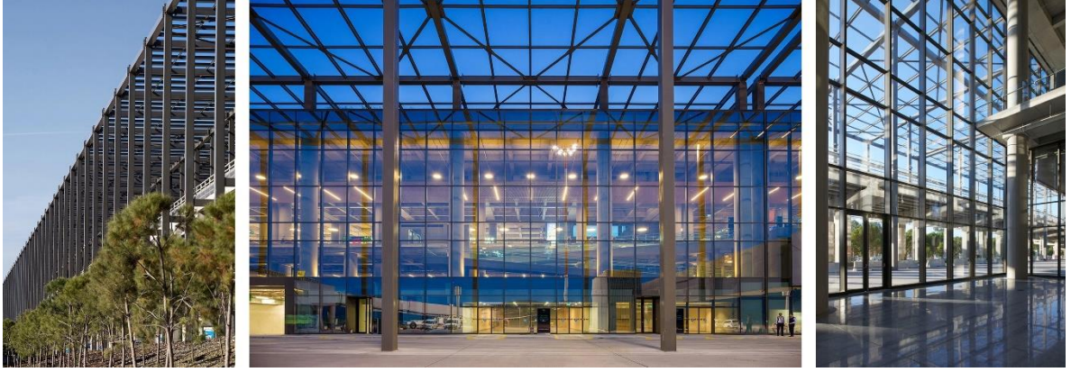
Şekil 4.10.3. Muğla'daki Dalaman Uluslararası Havalimanı giydirme cephe sisteminin bileşenleri ( https://emrearolat.com/project/dalaman-international-airport-terminal-ii/ ).
