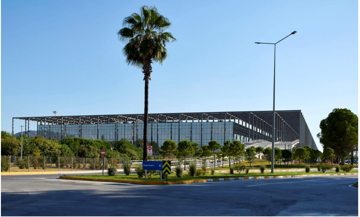
Şekil 4.10.1. Muğla'daki Dalaman Uluslararası Havalimanı, Türkiye ( https://emrearolat.com/project/dalaman-international-airport-terminal-ii/ ).
