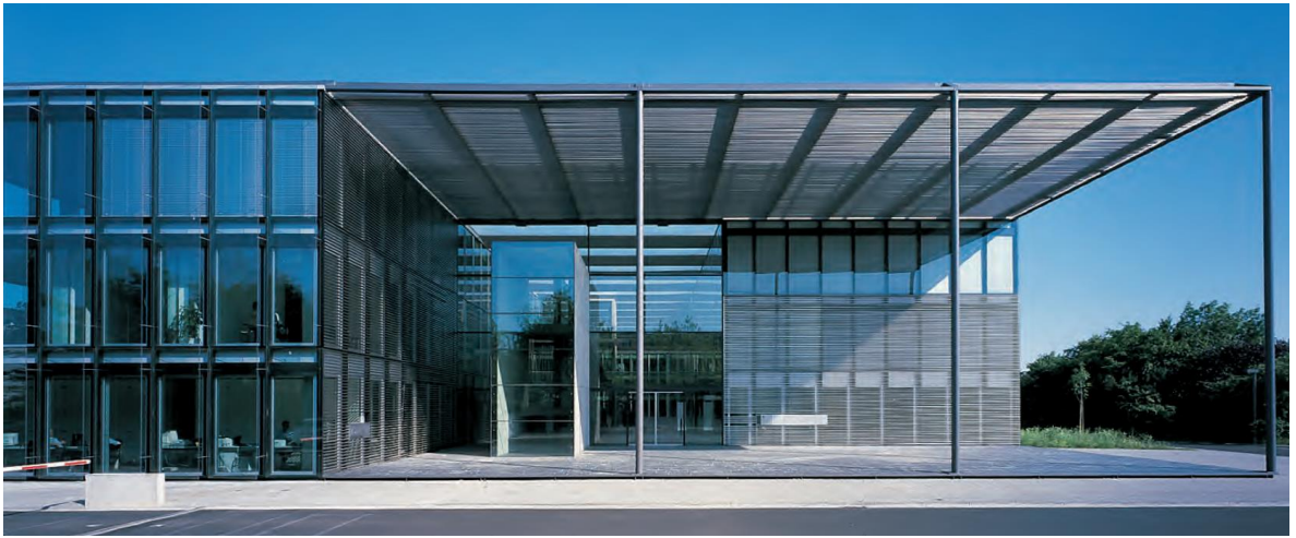
Şekil 4.2.6. Kronberg'deki Yönetim Binası giydirme cephesinin çeşitli malzemeleri (Schittich, C., 2007.).
