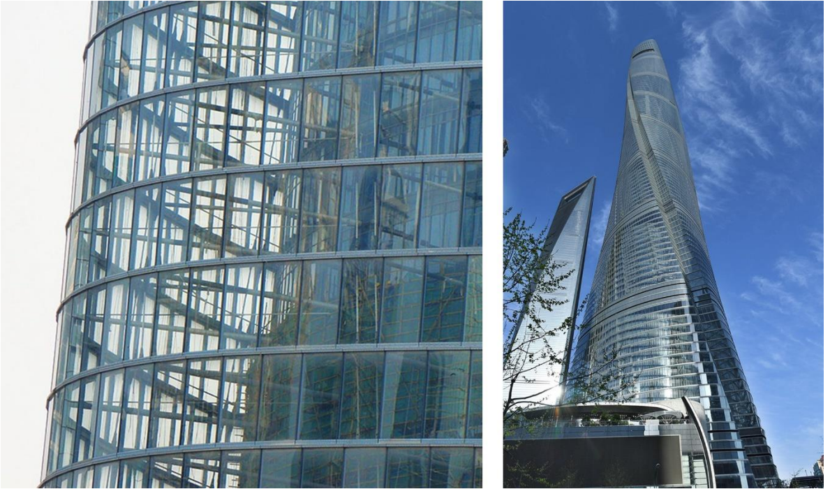
Şekil 4.8.2. Şangay Kulesi yapısal giydirme cephe sistemi ( https://www.gensler.com/projects/shanghai-tower ).
