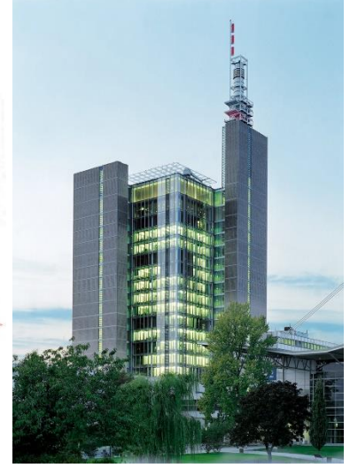
Şekil 4.1.2. Hannover'deki Ticaret Fuarı Kulesi hareketli havalandırma panjurları (Schittich, C., 2007.).
