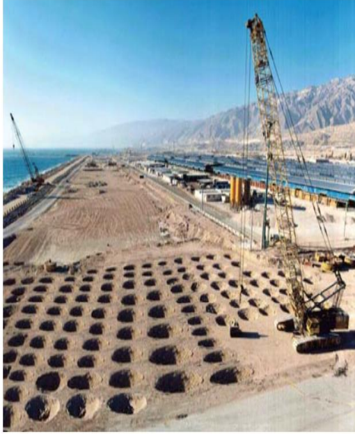
Şekil 2.3. Dinamik kompaksiyon uygulama yöntemi (Kaljahi ve Yasrobi, 2004)
