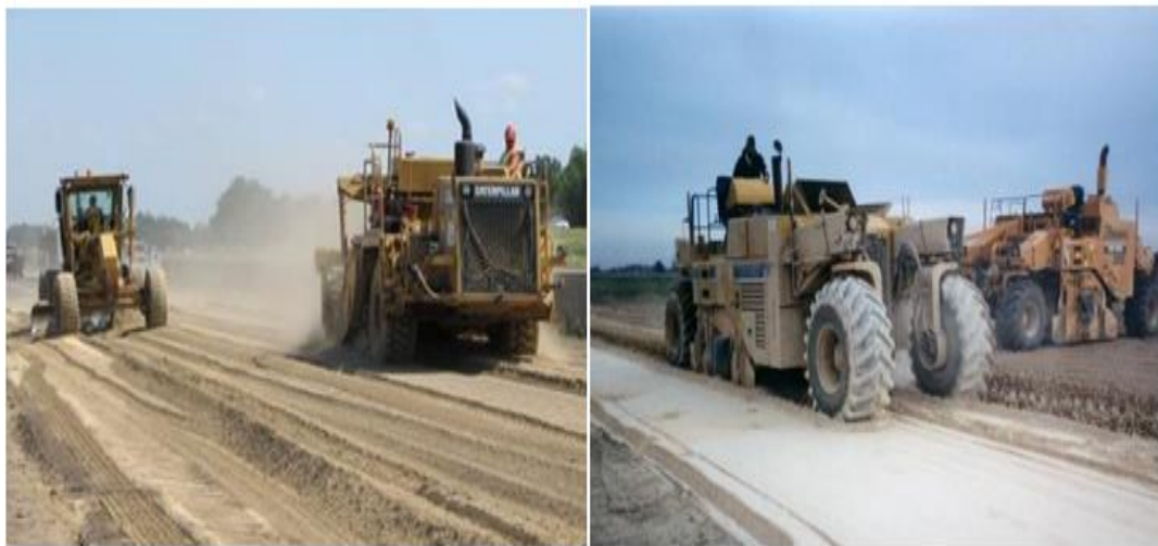
Şekil 2.7. Uçucu kül ile zemin stabilizasyon uygulaması (Hossain, 2012)
