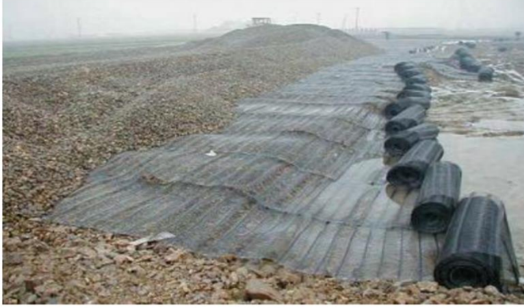
Şekil 2.10. Platformda Uygulanan Geosentetik ( Liu ve diğ., 2009)
