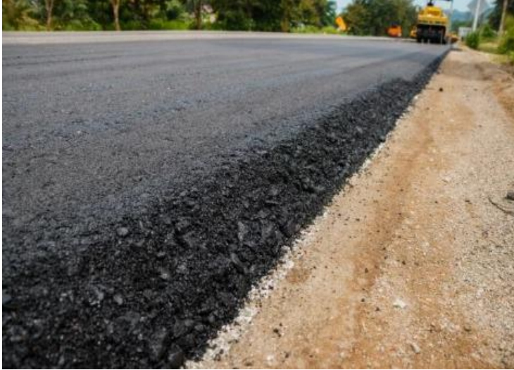
Şekil 2.8. Bitümlü malzemeler ile zemin stabilizasyonu
