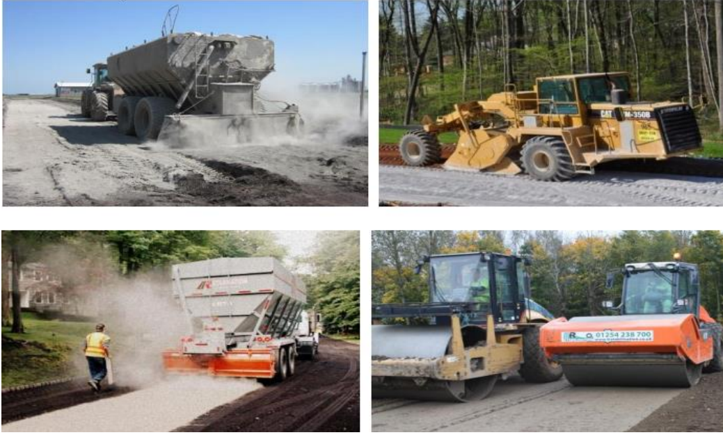
Şekil 2.6. Çimento ile zemin stabilizasyon uygulaması (Hossain, 2012)
