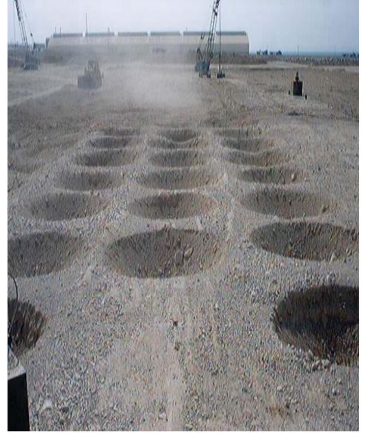
Şekil 2.3. Dinamik kompaksiyon uygulama yöntemi (Kaljahi ve Yasrobi, 2004)
