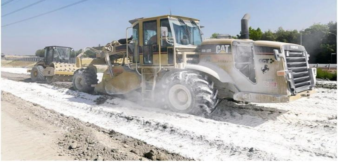
Şekil 2.5. Kireç ile zemin stabilizasyonu uygulaması (Hossain, 2012)
