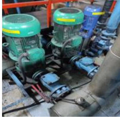
Şekil 4.16. Chiller Sirkülasyon Pompa Grubu Chiller 1-2 Numaralı Pompa
