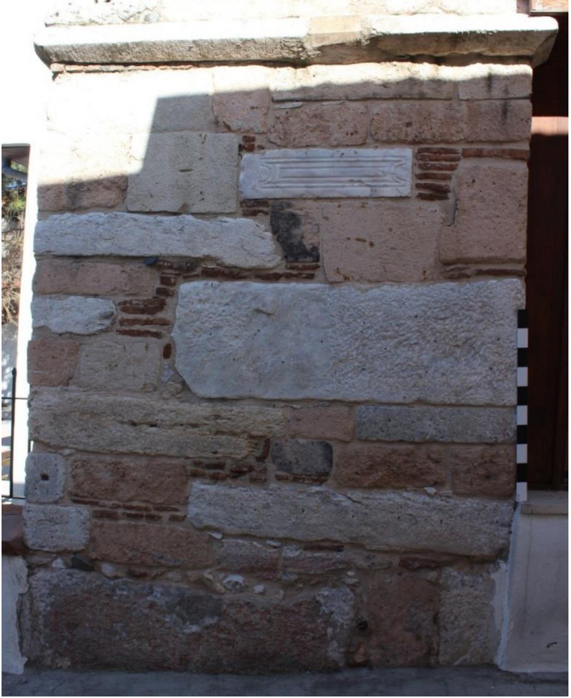
Res. 51. Müftü Camisi'nin minare kaidesinin batı yönündeki devşirme malzemeler.
