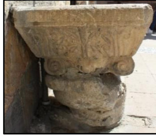
Çiz. 30c. Hacı Hasan Ağa Camisi'nin çeşmesindeki ion-impost sütun başlığının güney görünümü.
