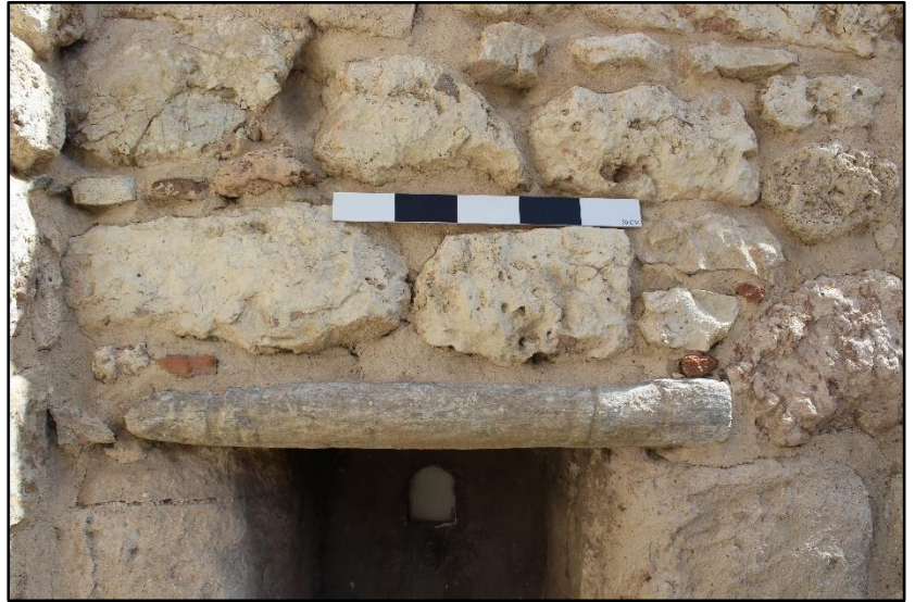
Çiz. 24. Kurşunlu Külliyesi'nin aşevinde lento olarak kullanılmış olan çifte sütunce.
