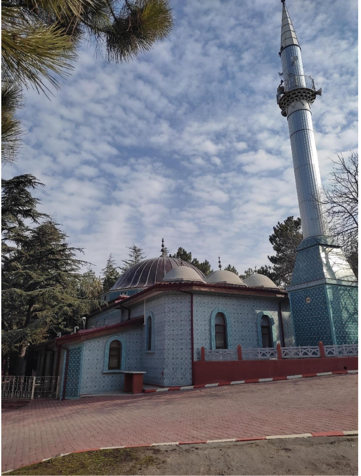
Hak Halili dergâhının dıştan görünümü.
