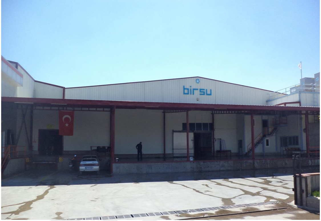
Şekil 4.1. Yalova İli Sınırlarında İncelemeye Alınan Soğuk Hava Deposu Örneği
