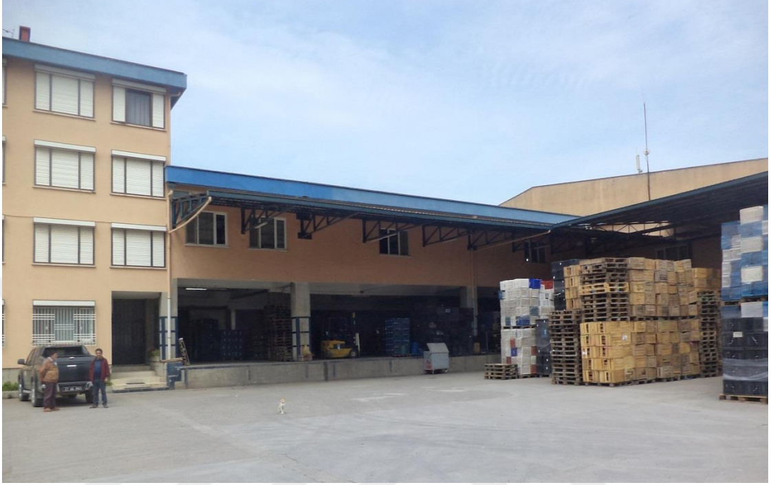
Şekil 4.5. 1995 Yılı Öncesinde İnşa Edilmiş Soğuk Hava Deposu (Çiftlikköy/YALOVA)
