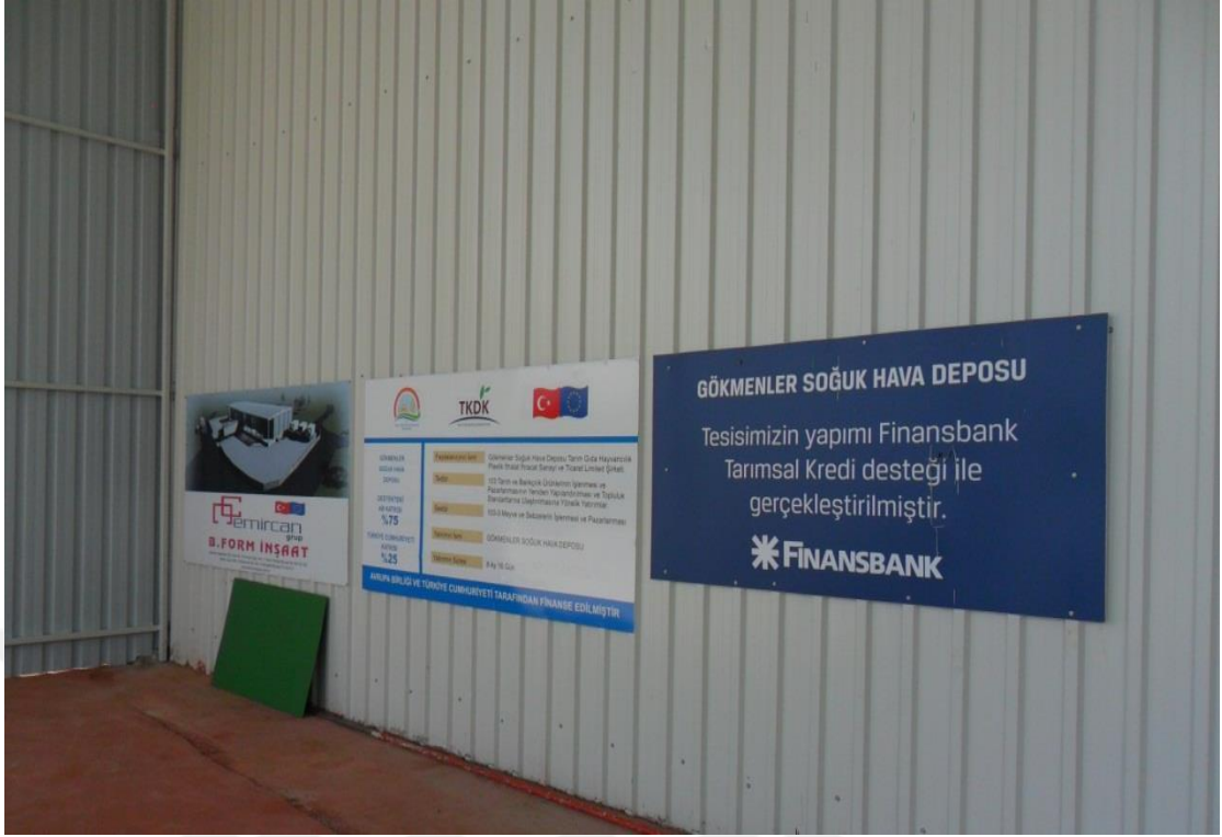
Şekil 4.31. KKYDP Kapsamında İnşa Edilen Soğuk Hava Deposu (Gürsu/BURSA)
