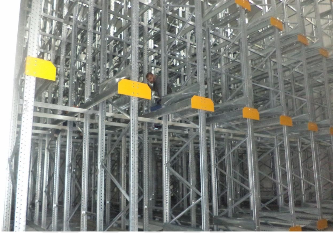
Şekil 4.33. KKYDP Kapsamında Depo İçi Raf Sistemi İnşası
