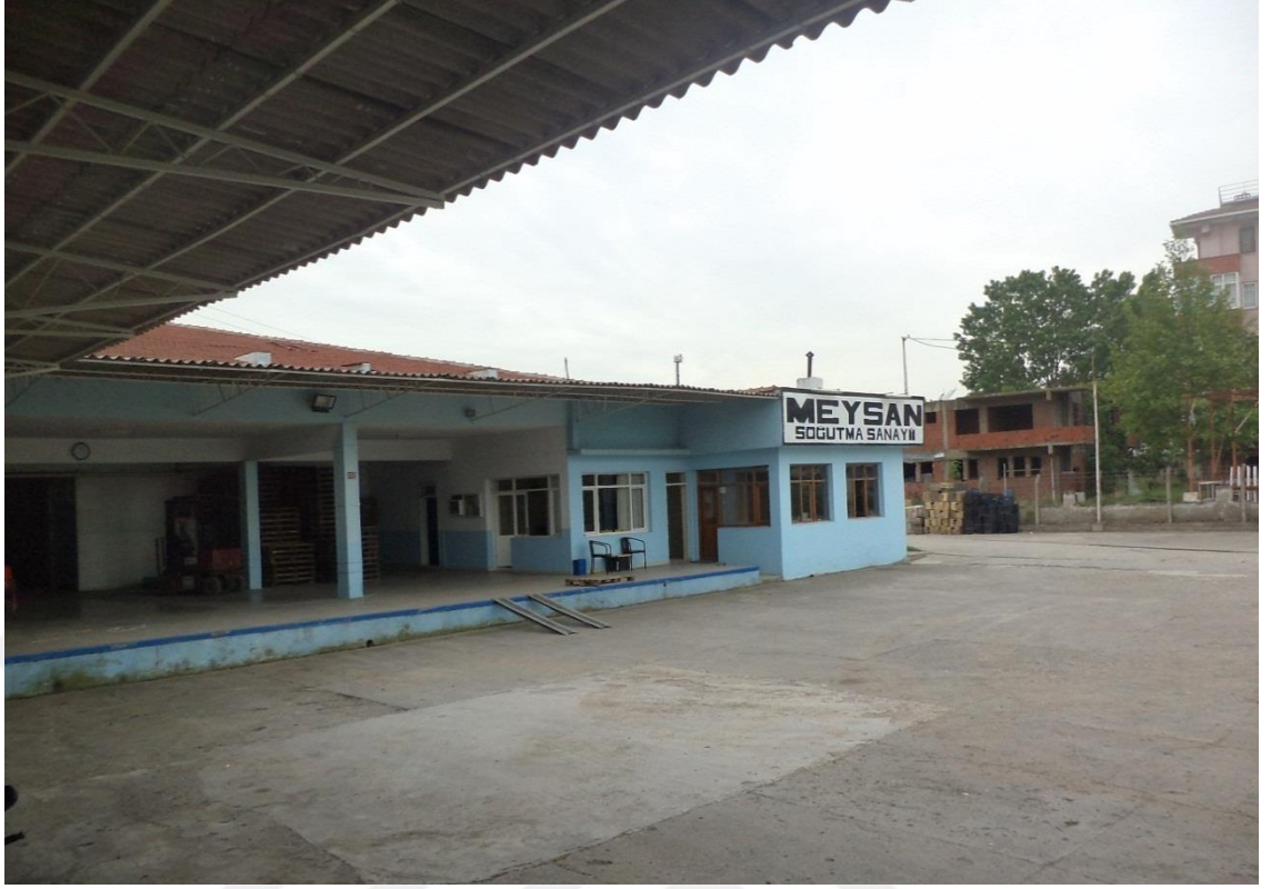
Şekil 4.4. İktisadi Şekli Limited Şirket Olan Soğuk Hava Deposu
