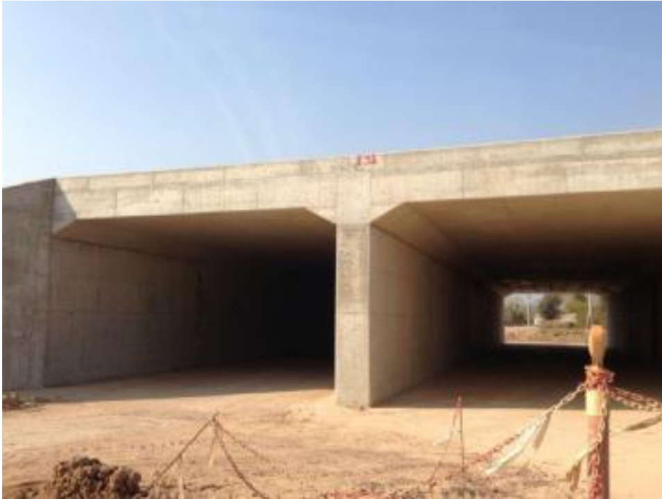
Şekil 3.6. Otoyol 4. istasyon yol yapım sonrası görünümü
