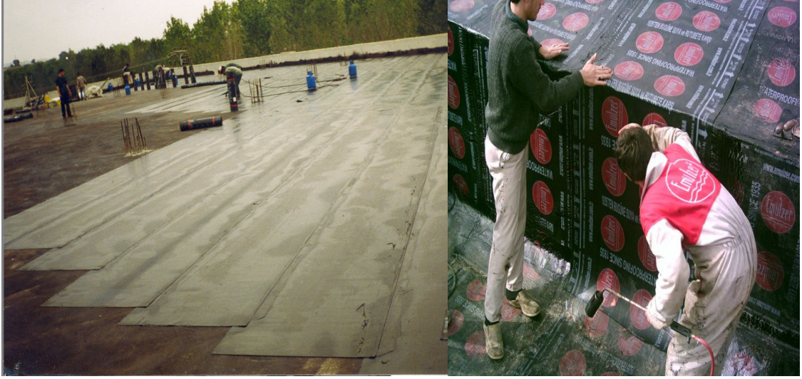
Şekil 2.56. Şalümo alevi ile bitümlü örtülerin bindirmeli olarak yüzeye yapıştırılması (İzonur Firması su yalıtımı uygulamaları)
