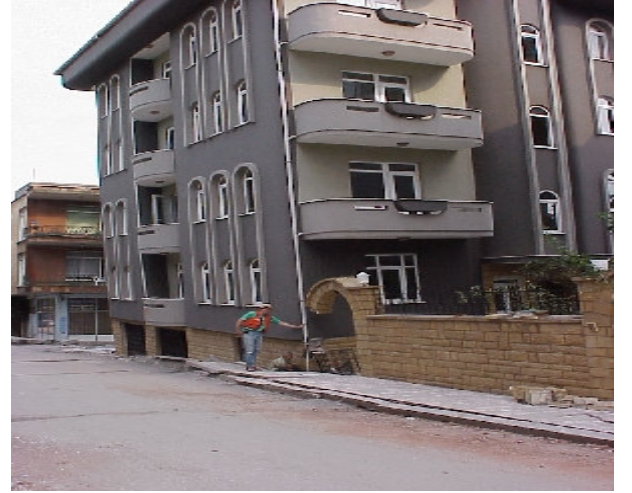
Şekil 2.2. b. Yapının zemine batması ( www.deprem.gov.tr )
