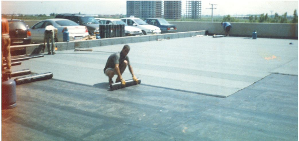
Şekil 2.55. Yalıtım örtülerinin astar kat üzerine yapıştırılması (İzonur Firması su yalıtımı uygulamaları)
