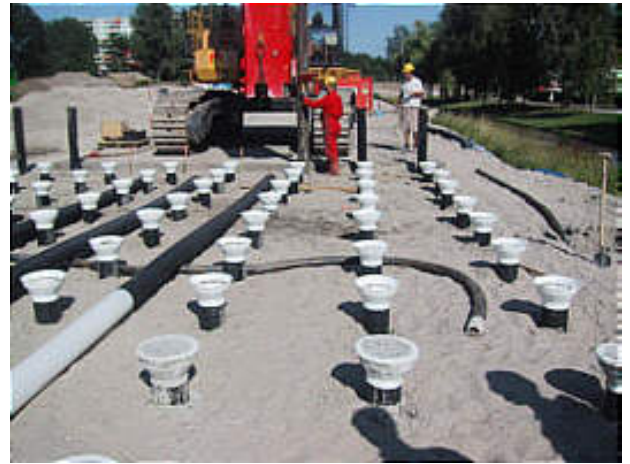
Şekil 2.32. Düşey Bant Dren uygulama örnekleri-2
