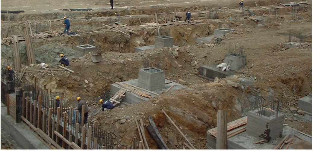
Şekil 2.6. Tekil temel yapım aşaması (Z. Şimşek arşivi 2004)
