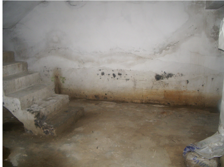
Şekil 3.9. Bodrum katta suyu kapiler yükselerek perde duvarı üzerinde oluşturulduğu hasarlar (Z.Şimşek arşivi 2005).
