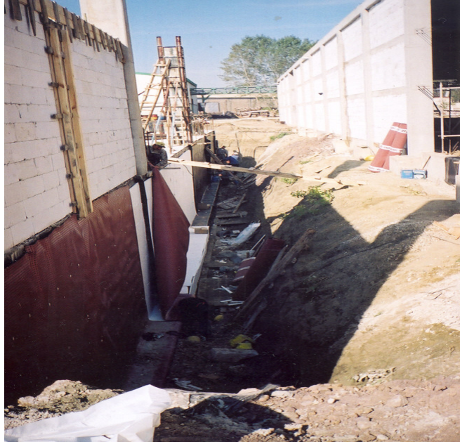
Şekil 2.35. Plastik malzemeler ile oluşturulan sızdırma malzemeleri drenaj örtüleridir (izonur Firması su yalıtım uygulamaları).
