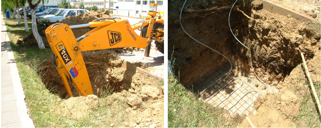
Şekil 3.5. TID ünitesinin içine konulacağı çukurun kazılması ve çukur içine yerleştirilmesi
