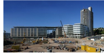
Şekil 2.34. Stuttgart 21 Projesi A1 bölgesindeki uygulama
