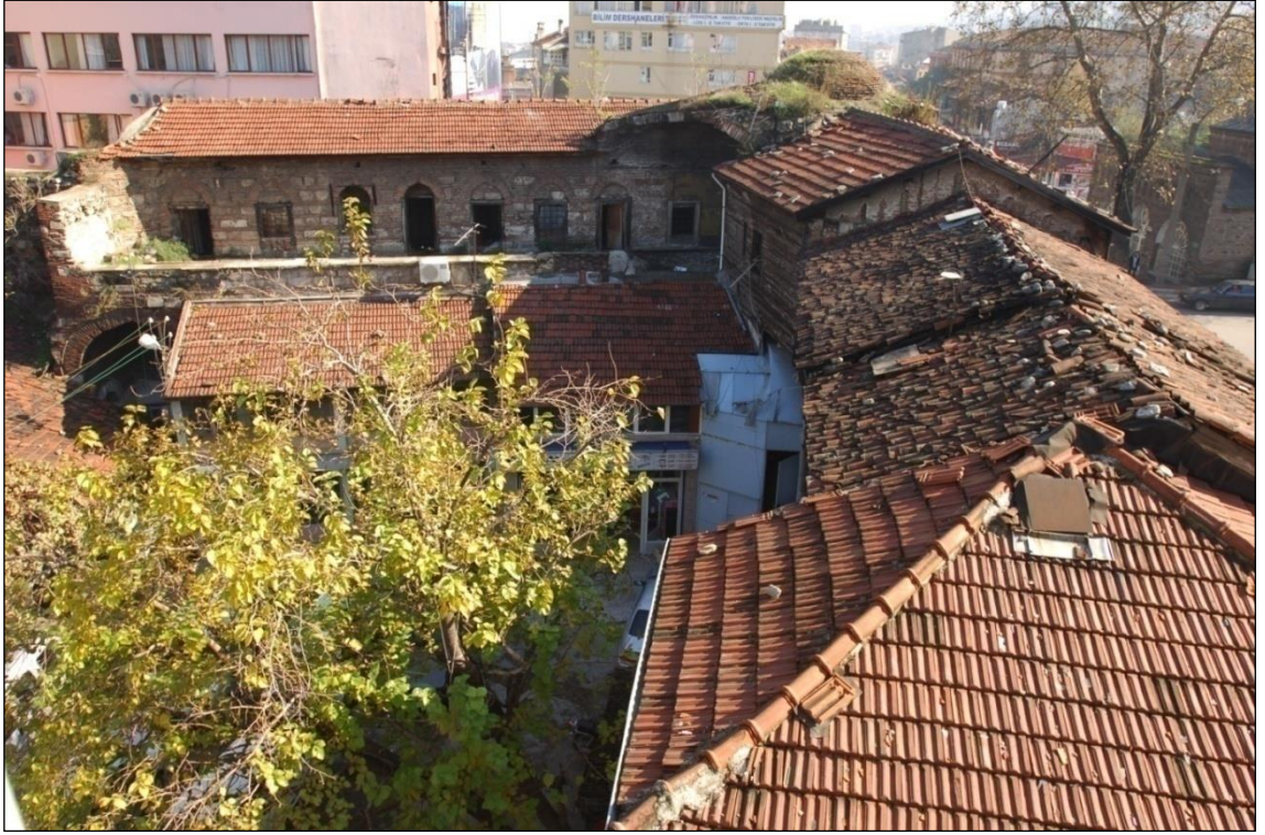
Şekil 61: Galle Han Genel Görünüm (Osmangazi Belediyesi Arşivi).
