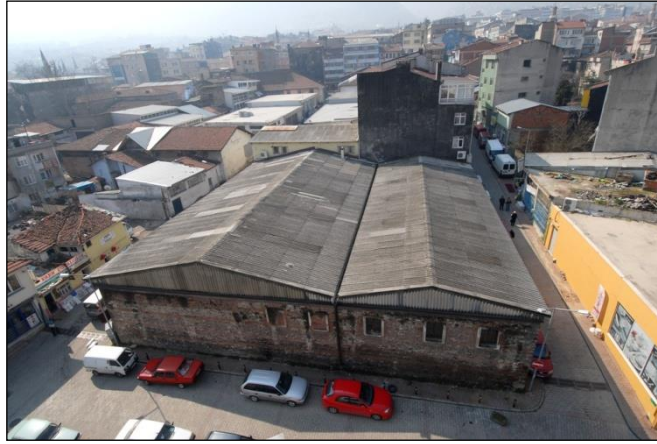
Şekil 49: Abdal Tahıl Deposu (Osmangazi Belediyesi Arşivi).
