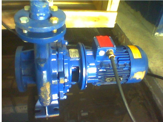
Şekil 5.3. KSB Marka, Betablock 32-125 Santrifüj Pompa
