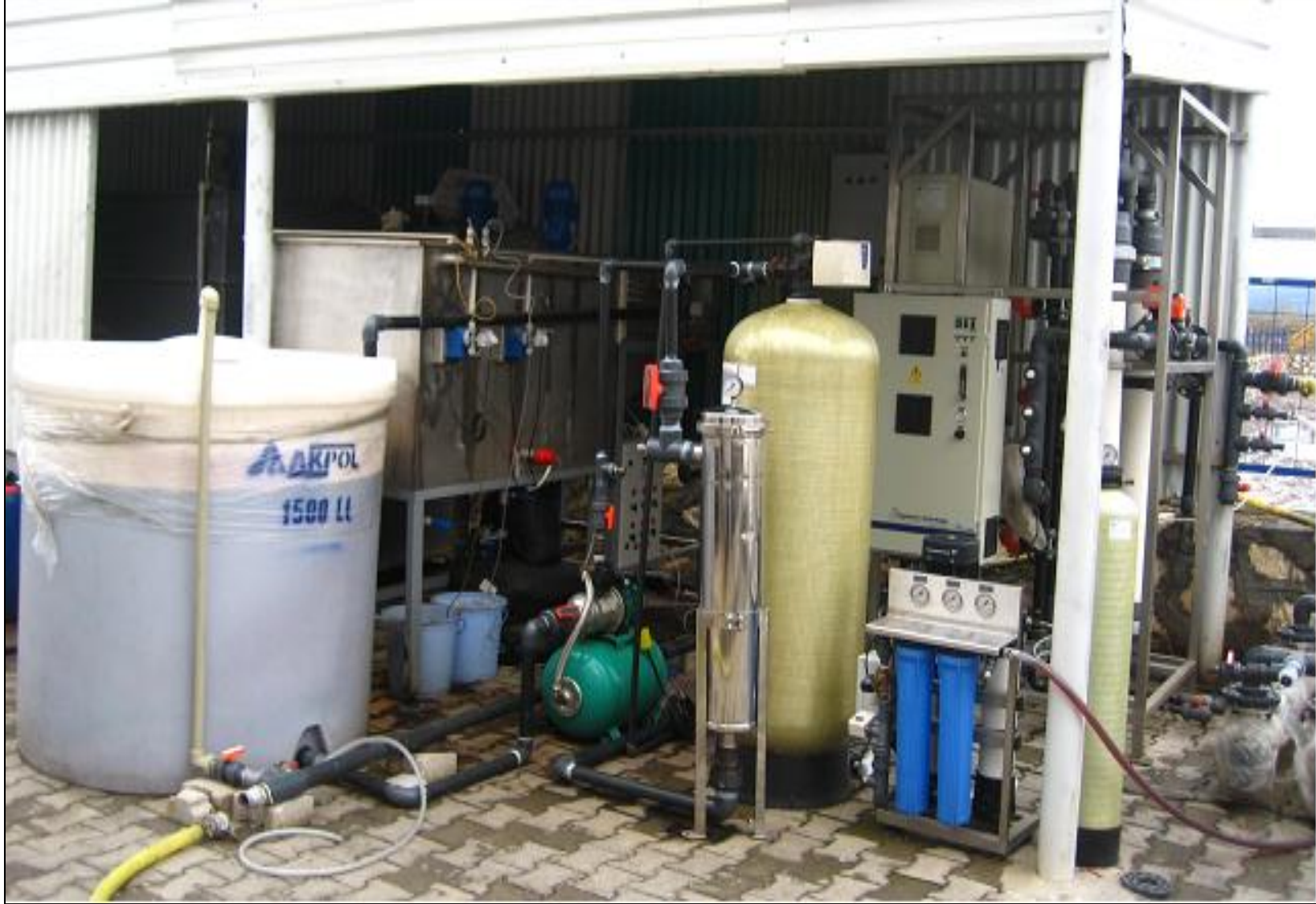
Şekil 2.3. Pilot Ölçekli Tesisin Genel Görünümü
