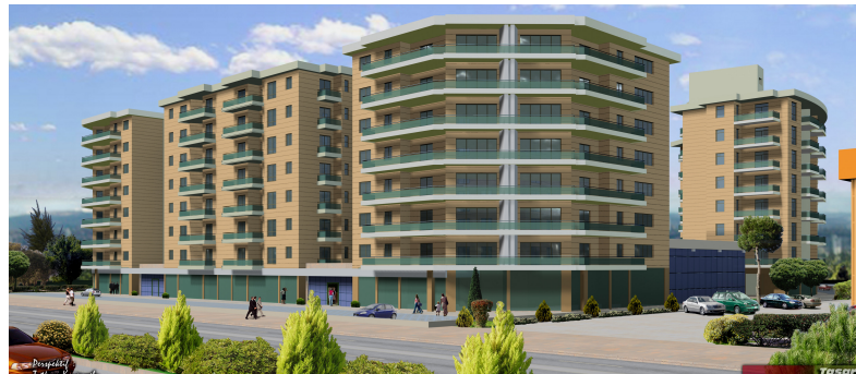
Şekil 5.57. Yol cephesi, alışveriş birimleri , Crystal Park (Tümer 2006)
