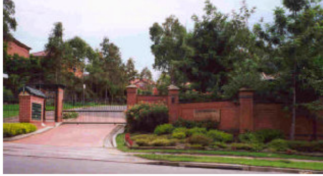
Şekil 3.50. The Manor Yerleşmesi giriş kapısı, Cherrybrook, Sydney (Burke 2001)
