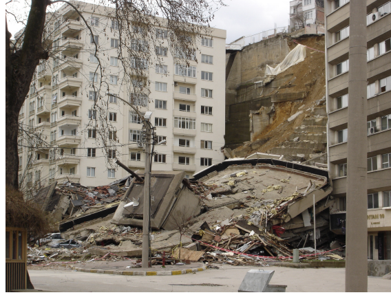
Şekil 5.18. 2006 yılında ani bir şekilde çöken İntam binalarından 95 ve 97 no'lu blok, Çekirge (Tümer 2006)
