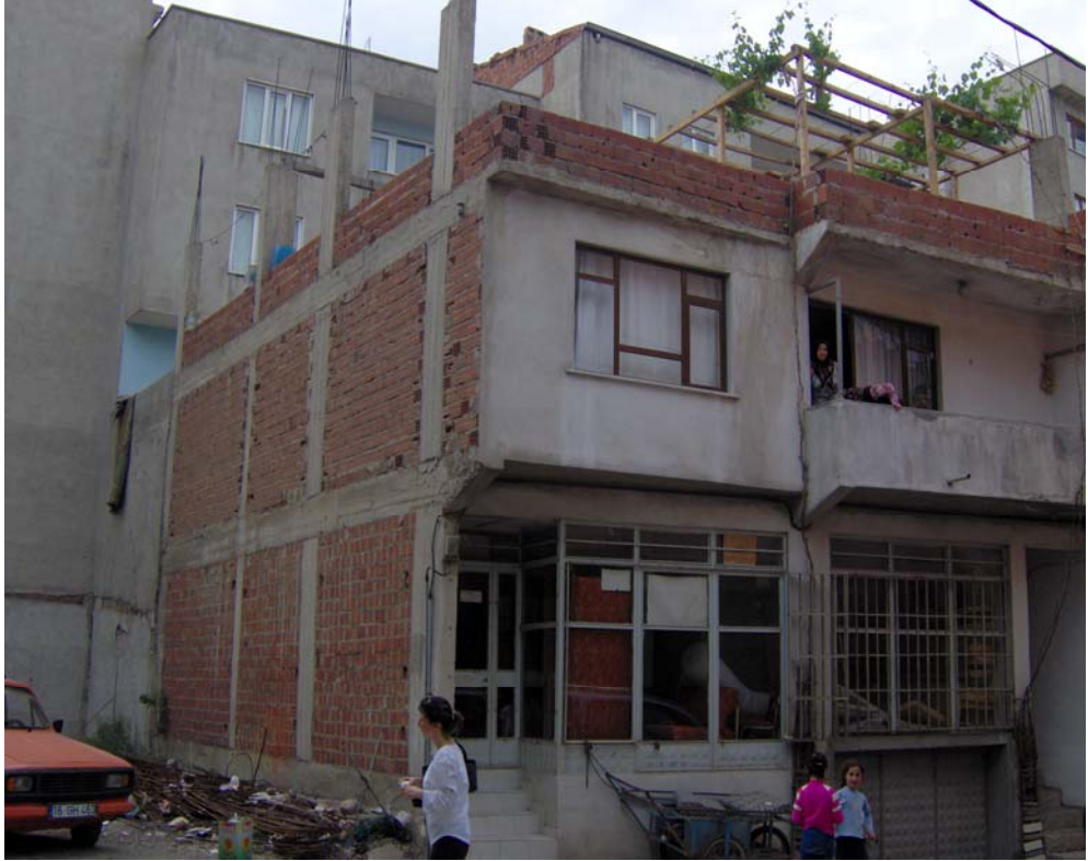
Şekil 6.7. Yapının genel görünüşü
