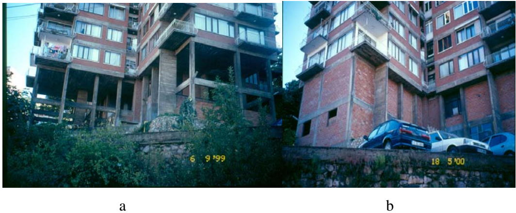
Şekil 4.21. Yumuşak katın dolgu duvarlarla iyileştirilmesi, 1999 -2000 Bursa -Çekirge
