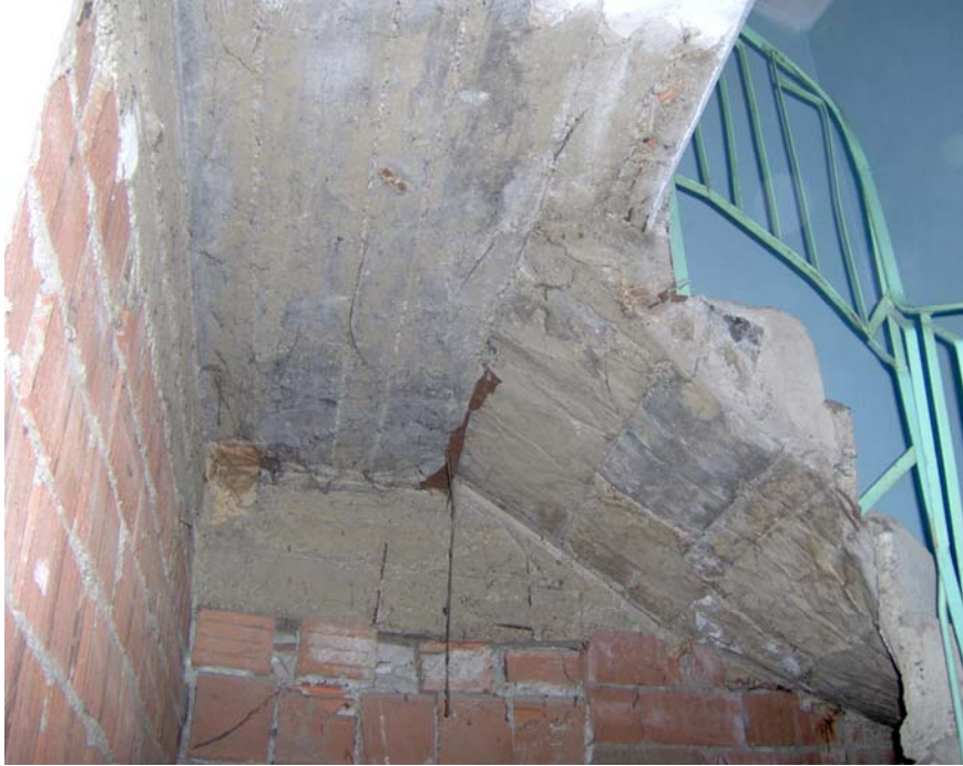
Şekil 6.11. Merdiven altından görünüş
