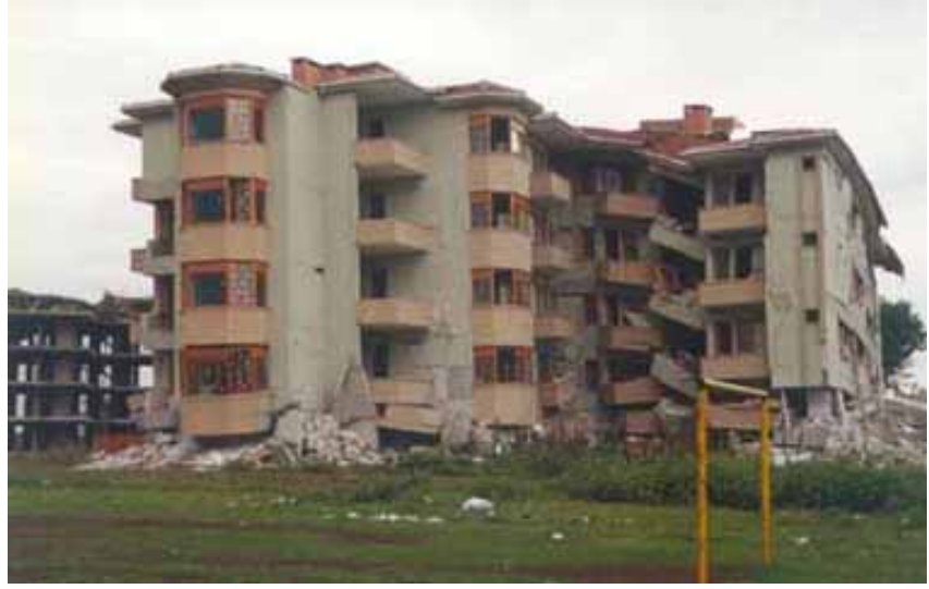
Şekil 4.9. Dilatasyon derzi ile ayrılmamış L plan tipinde bir yapının deprem karşısında davranışı
