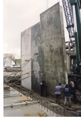
Şekil 2.79. Tilt-up panelin yerine montajı
