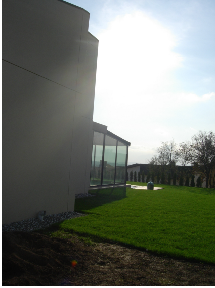
Şekil 4.19. Örnek binanın batı cephesi
