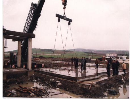
Şekil 2.34. Tilt-up panellerin ayağa kaldırılması
