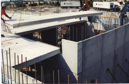
Şekil 2.56. Döşeme panelinin yerleşimi
