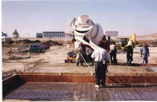
Şekil 2.69. Panel duvarın yüksekliđi fazla olduđu için, donatıların kalıba deđmesinin engellenmesi
