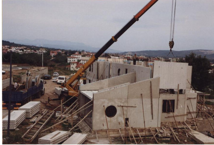
Şekil 4.8. Panellerin vinç yardımı ile yerleştirilmesi (Anonim 1)
