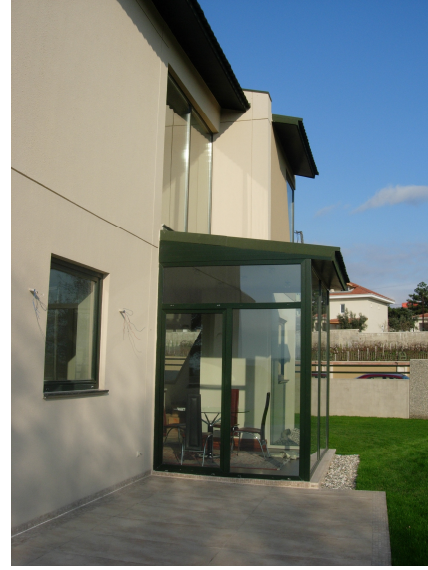
Şekil 4.20. Örnek binanın doğu cephesi
