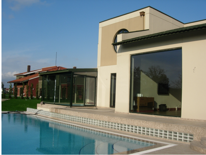
Şekil 4.18. Binanın güney cephesi, iç ve dış havuz bağlantısı (G.Yücedağ arşivi, 2005)
