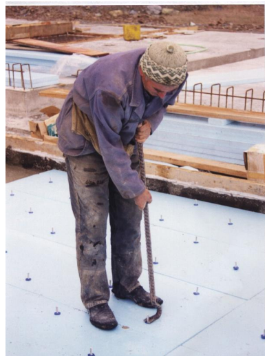
Şekil 2.17. Konektörlerin XPS 'e Yerleşimi
