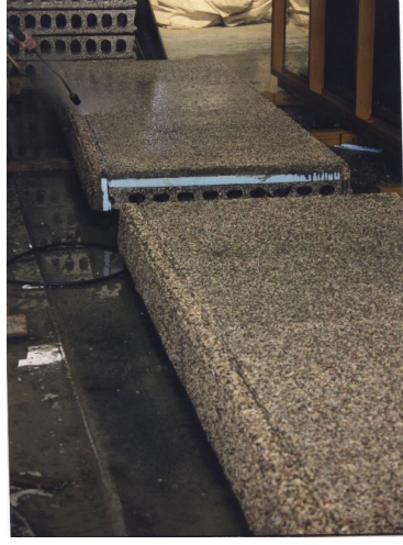
Şekil 2.65. Panelin granit ile kaplanması
