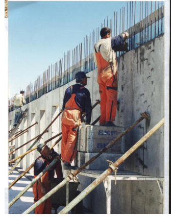
Şekil 2.53. Panellerin çaprazlamalarla desteklenmesi
