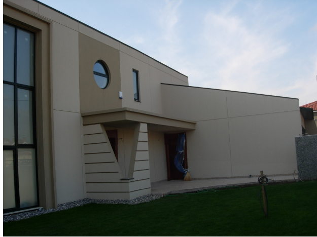
Şekil 4.15. Binanın kuzey rüzgarına karşı korunaklı oluşturulmuş girişi.
