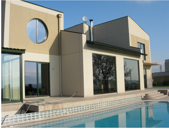
Şekil 4.17. Güney cephesi görünüşü (G.Yücedağ arşivi, 2005)
