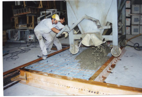
Şekil 2.47. Beton dökümü
