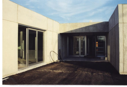
Şekil 2.59.Canlı Üretim Tesisleri İdari Bölüm Dış Görünüm
