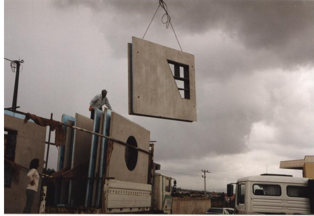
Şekil 4.5. Üretimi tamamlanan sandviç panellerin şantiyeye götürülmek üzere araca yerleştirilmesi (Anonim 1)
