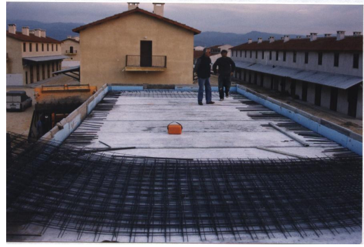
Şekil 2.67. Sandviç Panel Duvarların Teras Çatı İle Birleşimi
