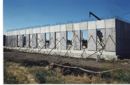
Şekil 2.57. Panellerin dışarıdan desteklenmesi
