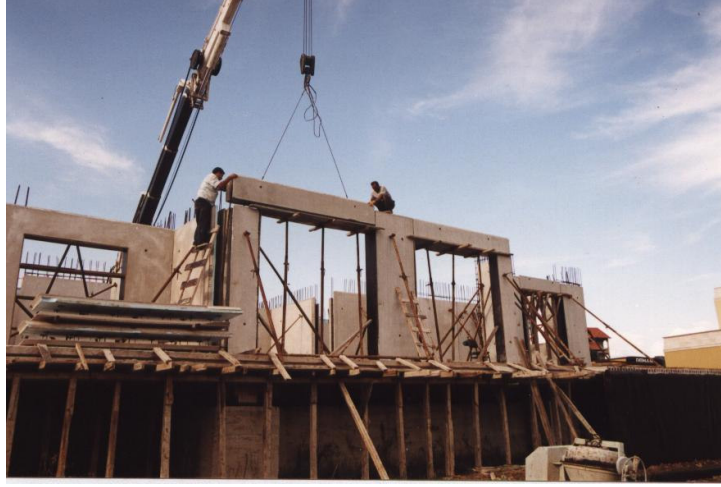
Şekil 4.7. Panellerin kapı üstü bölümlerinin vinçle montajı (Anonim 1)
