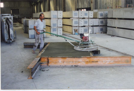
Şekil 2.48. Betonun düzeltilmesi
