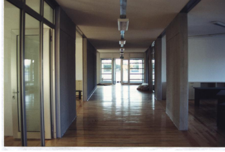
Şekil 2.58.Canlı Üretim Tesisleri İdari Bölüm İç Mekandan Görülen Panel Duvarlar
