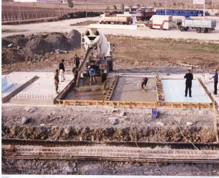
Şekil 2.33. Tilt-up panellere beton dökülmesi
