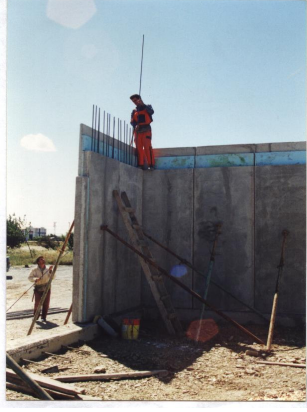
Şekil 2.52. Panellerin yerine yerleşimi Ve düşeyde rijitlenmesi
