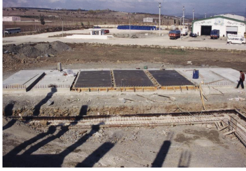
Şekil 2.77. Beton dökülen tilt-up paneller
