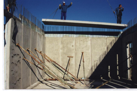
Şekil 2.55. Döşeme yerleşimini içeriden Görünüşü
