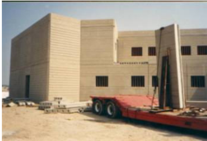
Şekil 2.26. Yalıtımlı beton sandviç panellerin prekast / öngerilmeli yapımı Mansfield Rehabilitasyon Merkezi, Ohio (Anonim 5, USA)
