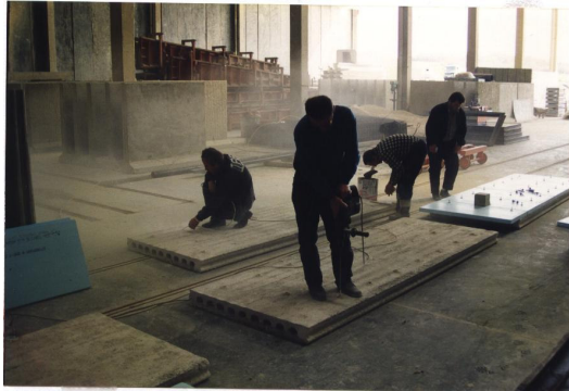
Şekil 2.62. Betona deliklerin açılması
