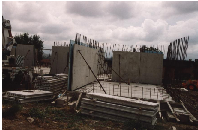
Şekil 4.6. Araçtan indirilen panellerin şantiyede yerine montajı (Anonim 1)
