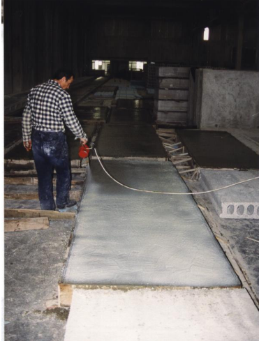
Şekil 2.64. Betona koruyucu Tabaka püskürtülmesi
