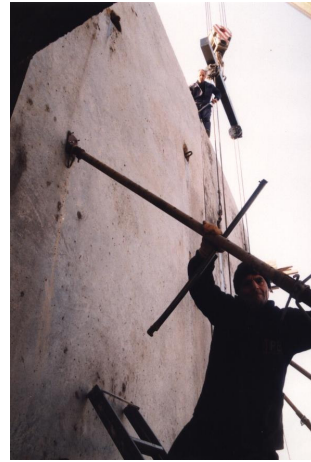
Şekil 2.36. Tilt-up panellerin desteklenmesi
