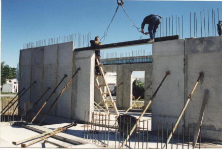
Şekil 2.54 Kapı lentosunun yerleşimi
