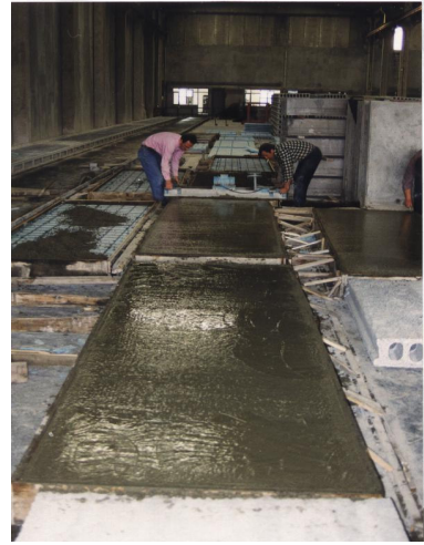
Şekil 2.61. panelin kalıp içinde beton dökümünden sonraki durumu
