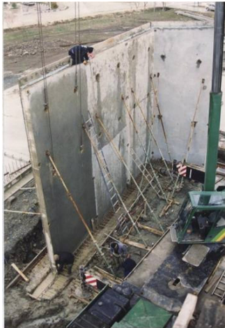
Şekil 2.35. Tilt-up panellerin yerine sabitlenmesi Megablok Sistem
