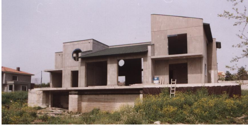
Şekil 4.13. Binanın kaba inşaat güney cephesi (Anonim 1)
