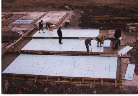
Şekil 2.73. Tilt-up panele XPS'lerin yerleşimi
