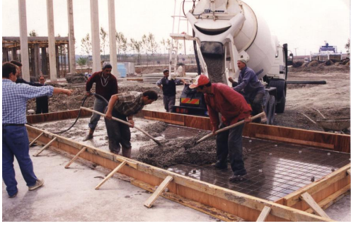
Şekil 2.71. Beton döküm işlemi
