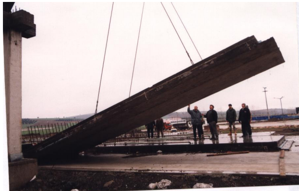
Şekil 2.29. Marmara Zeytin Birliği için üretilen Beton Sandviç paneller duvarın tilt-up sistemi ile yerde yatay dökülüp ayağa kaldırılması
