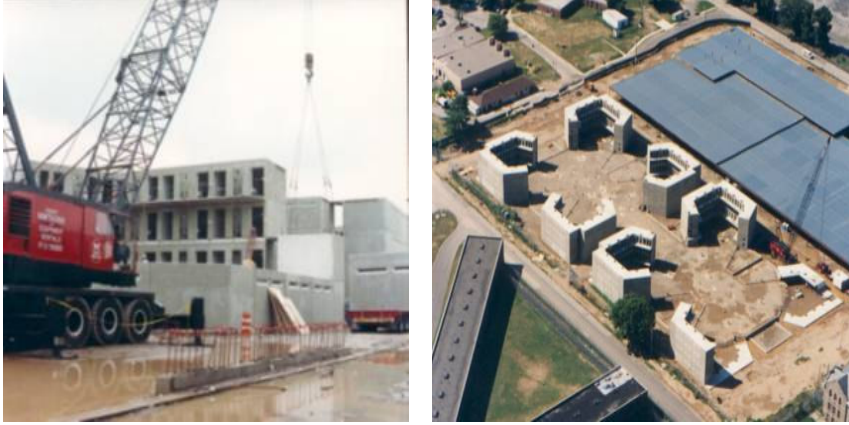
Şekil 2.27. Yalıtımlı beton sandviç panelleri ile prekast / modüler olarak üretilen Philadelphia, Pennsylvania Curran-Fromhold Correctional Facility Binası (Anonim 5, USA)
