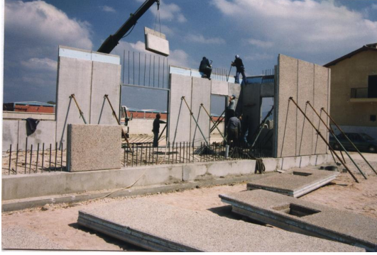
Şekil 2.66. Sandviç Panel Duvarların Yerine Montajı
