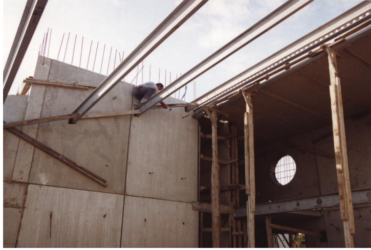
Şekil 4.10. Çatı çelik kirişlerinin içeriden görünümü (Anonim 1)
