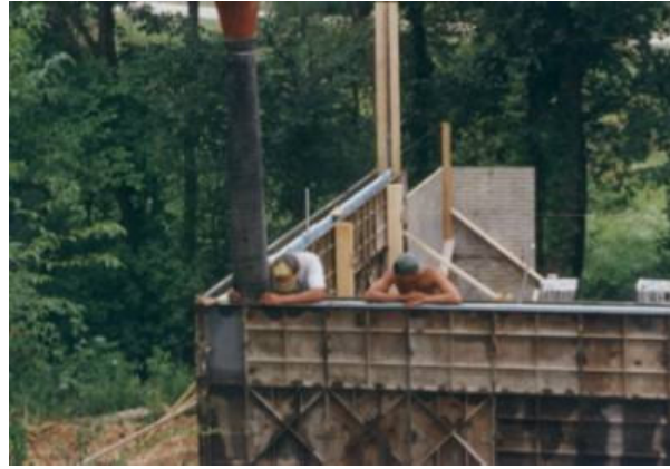
Şekil 2.28. Yalıtımlı beton sandviç panellerin yerinde düşey kalıba dökülmesi
