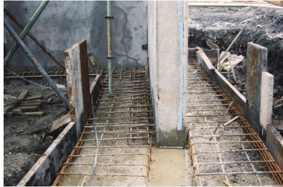
Şekil 2.80. Tilt-up sandviç panellerin temele montajı
