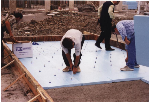
Şekil 2.18. Konektörlerin panele yerleşimi
