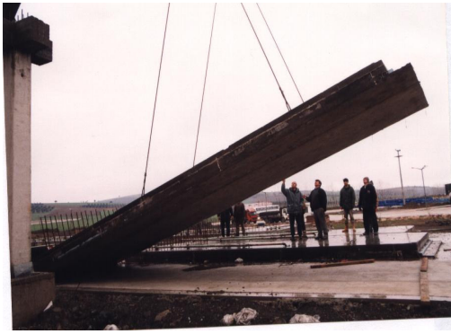
Şekil 2.78. Tilt-up panelin vinç Yardımı ile kaldırılması
