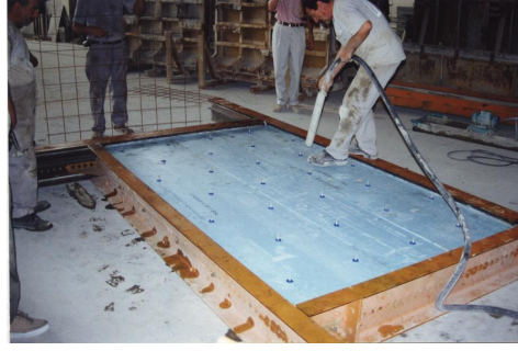
Şekil 2.45. Vibratör ile sıkıştırılması
