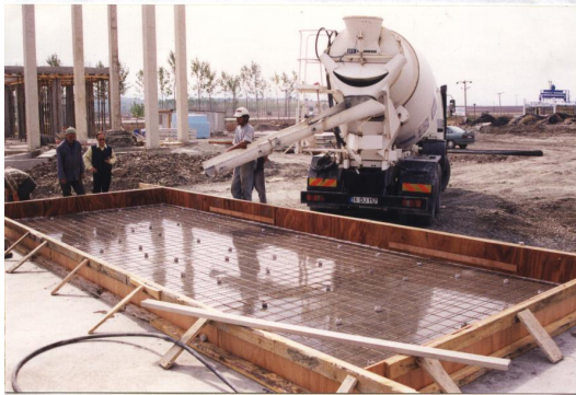
Şekil 2.70. Donatıları yerleştirilen panel kalıbı beton dökümüne hazır.
