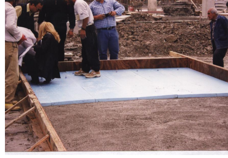
Şekil 2.72. Sandviç panelin iki beton yüzeyi arasında XPS'lerin yerleştirilmesi
