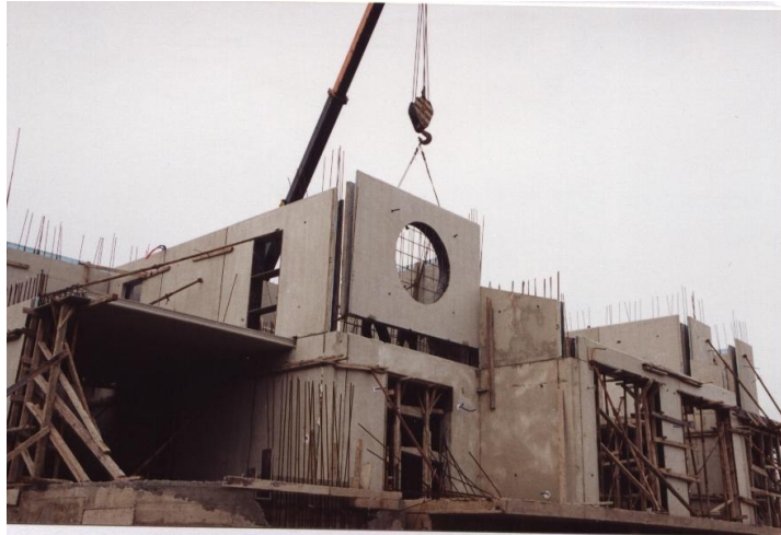
Şekil 4.9. Sandviç panellerin yerine montajı (Anonim1)
