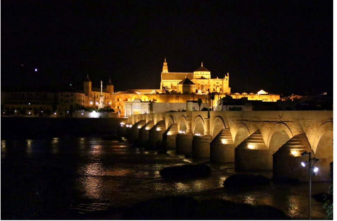
Resim 1: Kurtuba Cami Gece Dış Görünüşü
